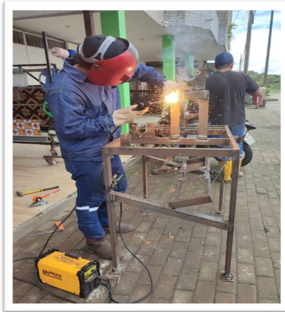
Figura 4.12: Soldar soportes de las bombas.
