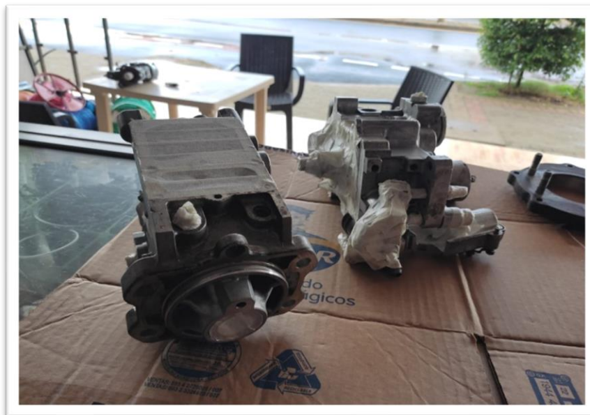
Figura 4.5: Tapar bombas para pintar.
