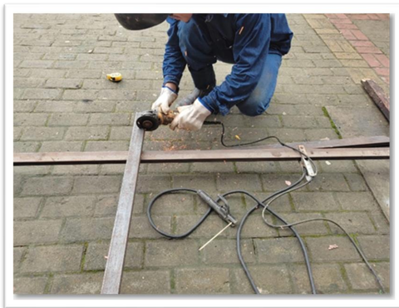
Figura 4.9: Corte de tubos para la estructura.
