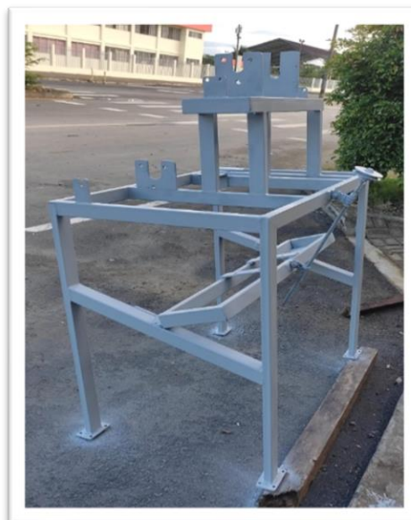
Figura 4.15: Aplicación de fonde en la estructura.
