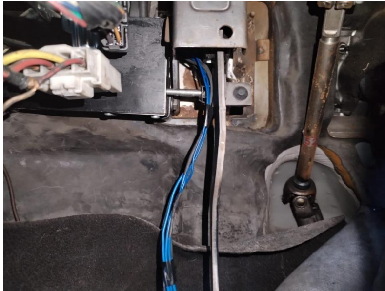
Figura 3.12. Instalación del Sistema mecánico
