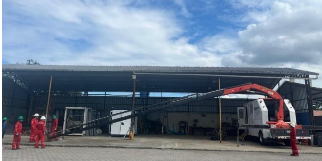
Figura 4.5: Despliegue de la grúa
