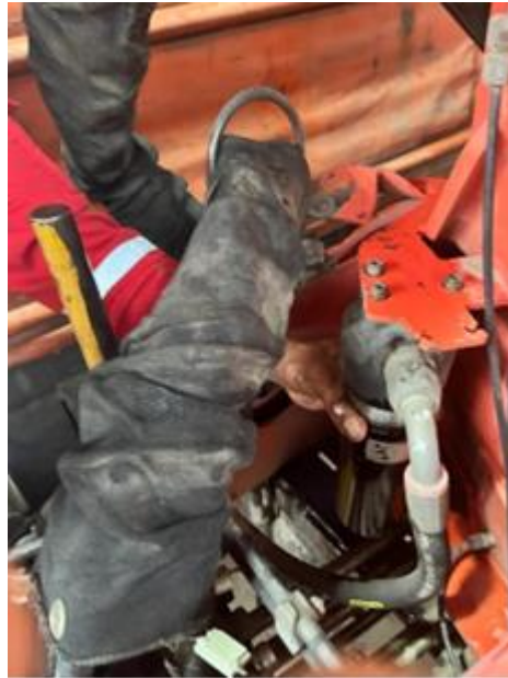
Figura 4.4: Colocación del filtro hidráulico Palfinger.
