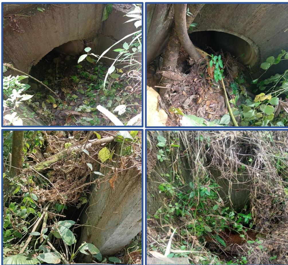
*Nota:* En la primera imagen se muestra la alcantarilla en estado BUENO, la siguiente alcantarilla en estado REGULAR y las dos últimas imágenes muestran las alcantarillas en estado DEFICIENTE O MALA. Elaborado por: Los Autores.
