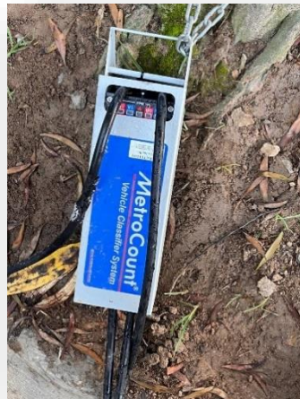
Anexo 6 RoadPod correctamente instalado.
