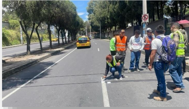
Anexo 1 Instalación del equipo en la vía Rumichaca Ñan.
