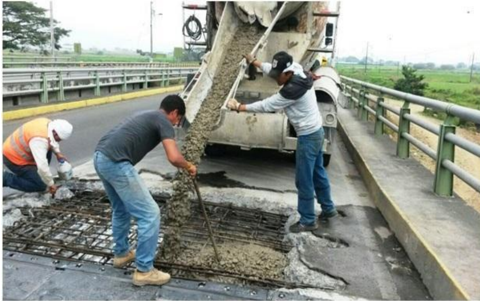
Figura 2-17 Reparación de la losa en el puente de Babahoyo- Ecuador (junio-2019). Fuente: Autores.
