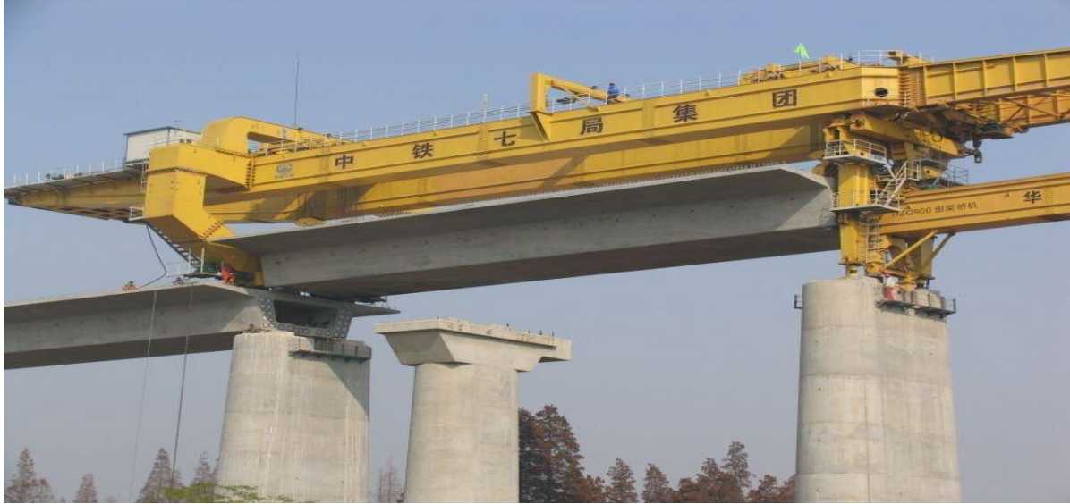
Figura 2-18 Construcción de puentes mediante lanzador de vigas. Fuente: Universidad Politécnica de Valencia.
