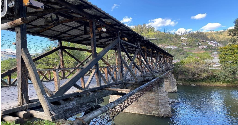
Figura 2-4 Puente Velasco Ibarra en el Cantón Gualaceo (junio-2024). Fuente: Autores.
