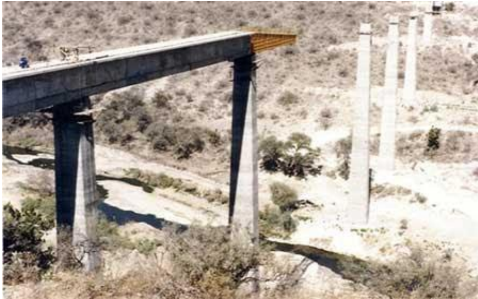
Figura 2-3 Construcción de Puente Ferroviario San Juan, Jalisco.
