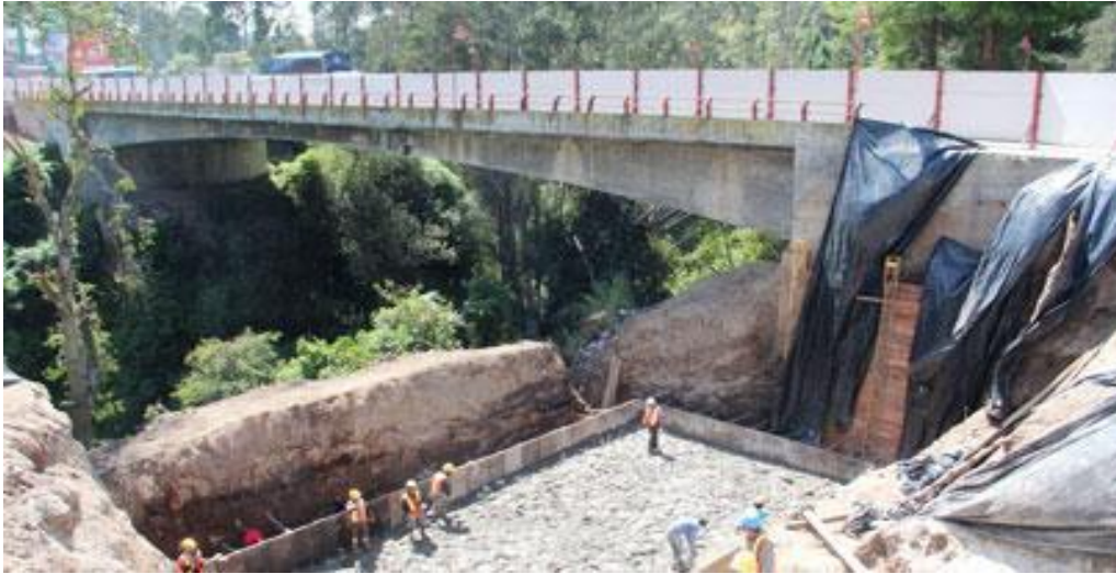
Figura 2-20 Fundición de estribos para el puente internacional Rumichaca Frontera entre Ecuador y Colombia (enero-2012). Fuente: Autores.
