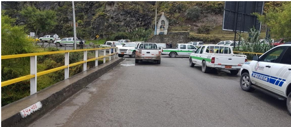
Figura 2-8 Puente de Chicti ubicado en el cantón Paute provincia del Azuay (octubre-2019). Fuente: Autores.
