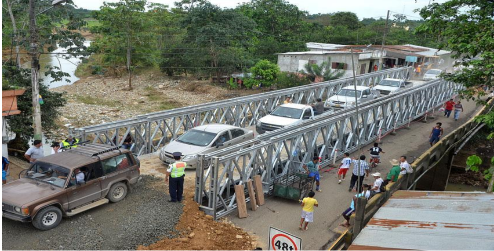
Figura 2-30 Todos los vehículos que pasan por el puente Bailey sobre Río Bonito-Ecuador pertenece a la carga variable, (enero-2016). Fuente: Autores.
