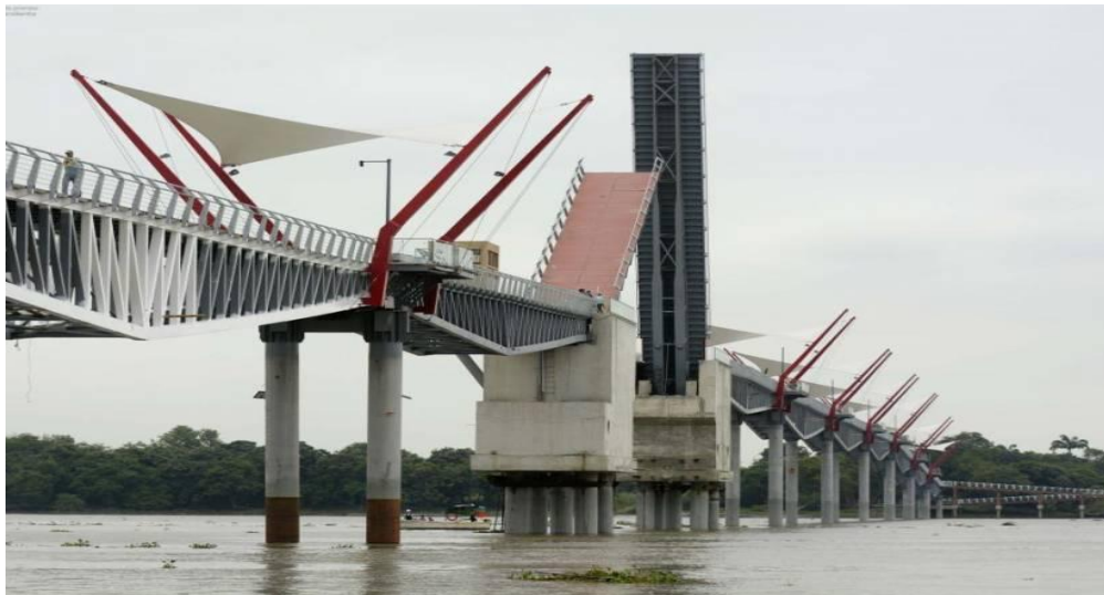
Figura 2-16 Puente para uso peatonal a la isla Santay (agosto-2022). Fuente: Autores.
