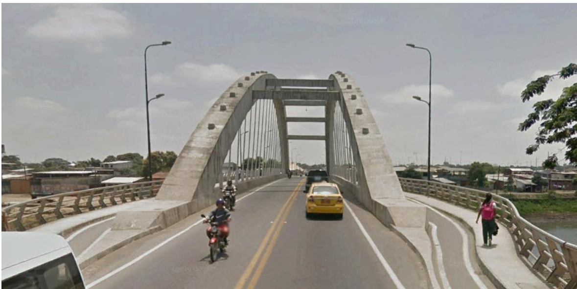
Figura 2-15 Puente de arco de 100m de longitud ubicado en Babahoyo-Ecuador. Fuente: Google Earth Pro
