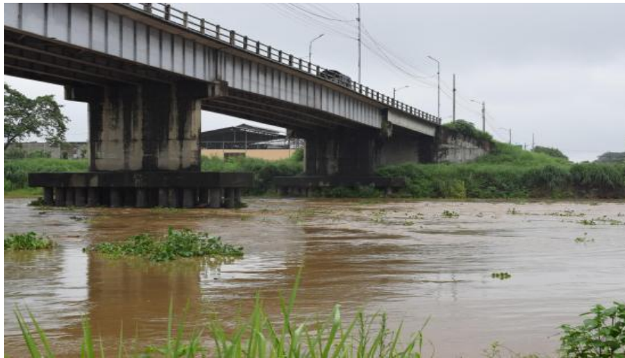
Figura 2-34 Fuerza del río Quevedo-Ecuador sobre las pilas del puente (enero-2020). Fuente: Autores.
