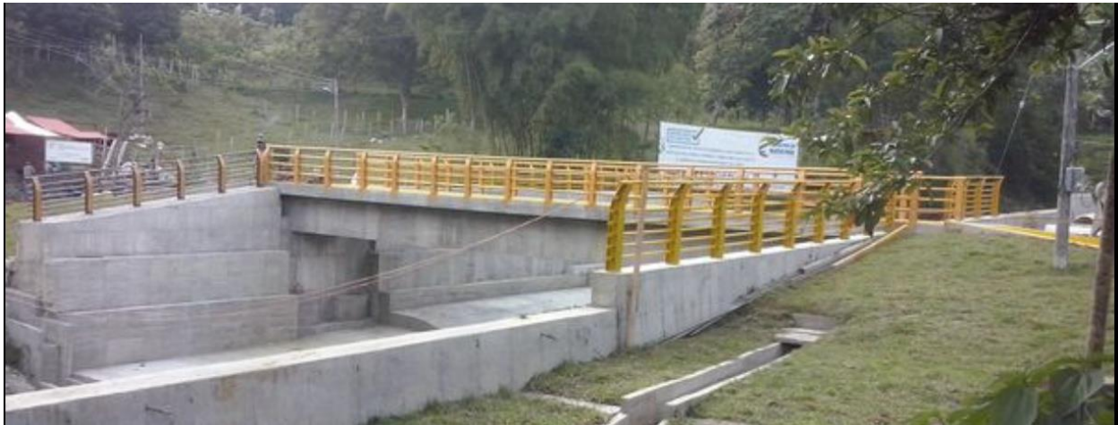
Figura 2-19 Pasamanos para puentes tipo pingüino (febrero- 2017). Fuente: Autores.
