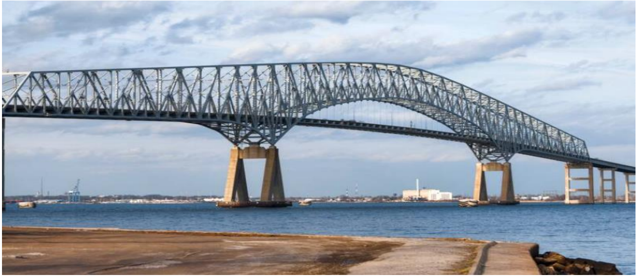
Figura 2-11 Puente Francis Scott Key de Baltimore, Estados Unidos (abril-2024). Fuente: Google Earth Pro
