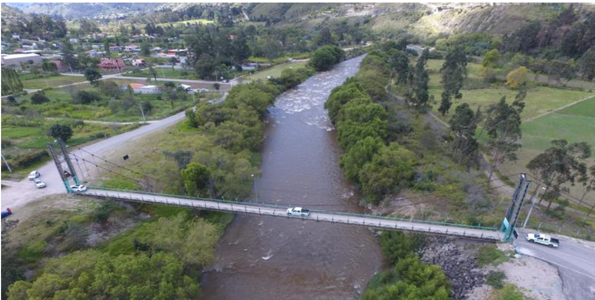
Figura 3-1 Puente "La Unidad" exclusivo para vehículos pequeños (mayo-2024). Fuente: Autores.
