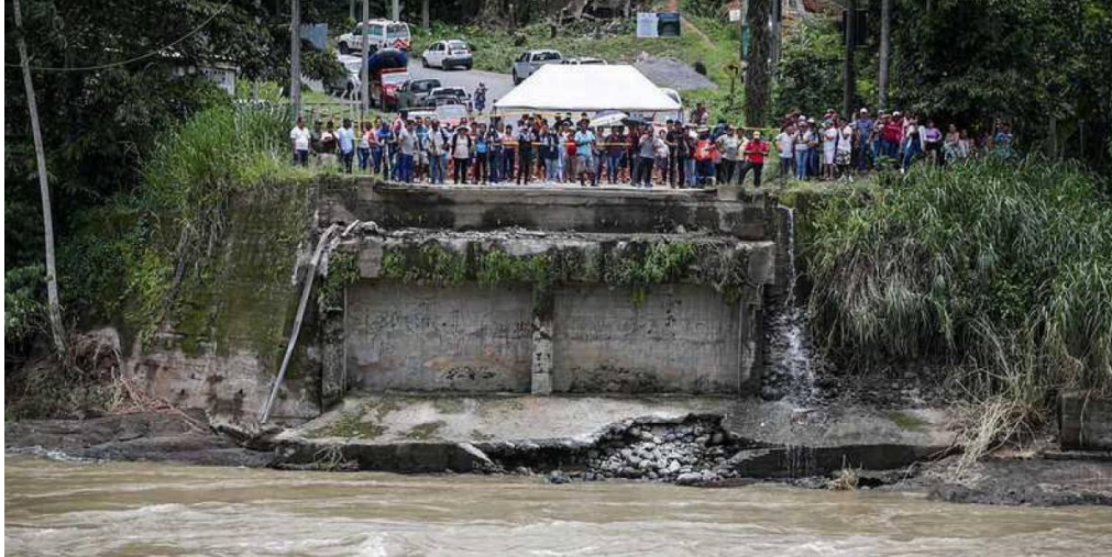
Figura 2-21 Estribo sobre el rio Blanco-Esmeraldas (mayo-2023). Fuente: Autores.
