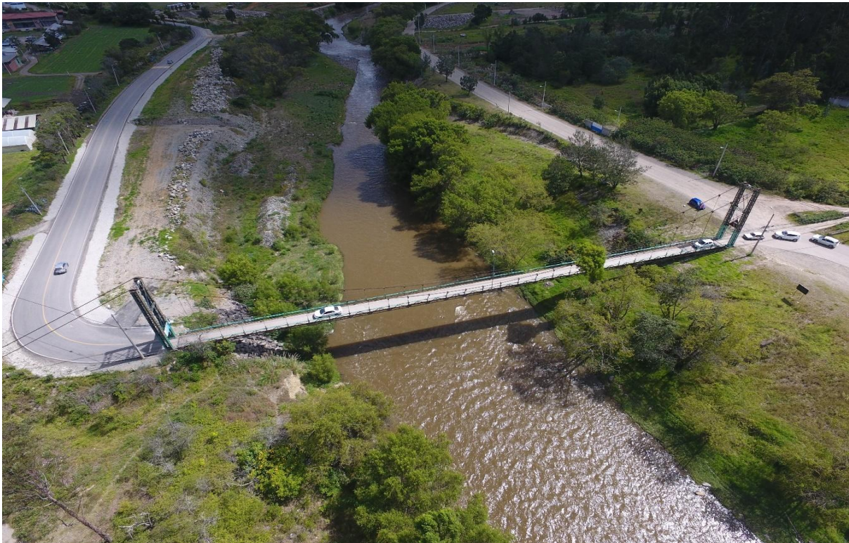
Figura 1-2 Puente Unidireccional "La Unidad", congestión vehicular (mayo, 2024). Fuente: Autores.
