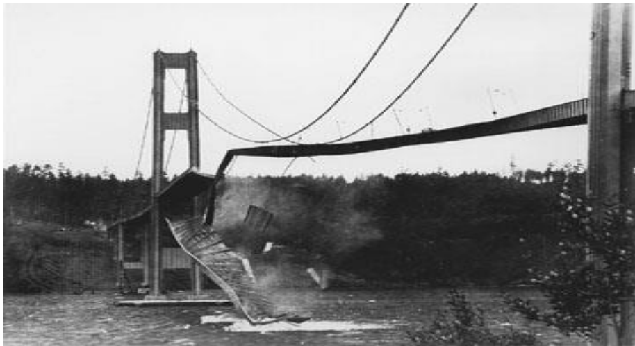
Figura 2-31 Una carga de viento afectó al puente Tacoma Narrows.
