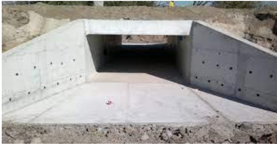
Figura 2-22 Construcción de puente usando estribos con aleros en ángulo (febrero-2014). Fuente: Autores.
