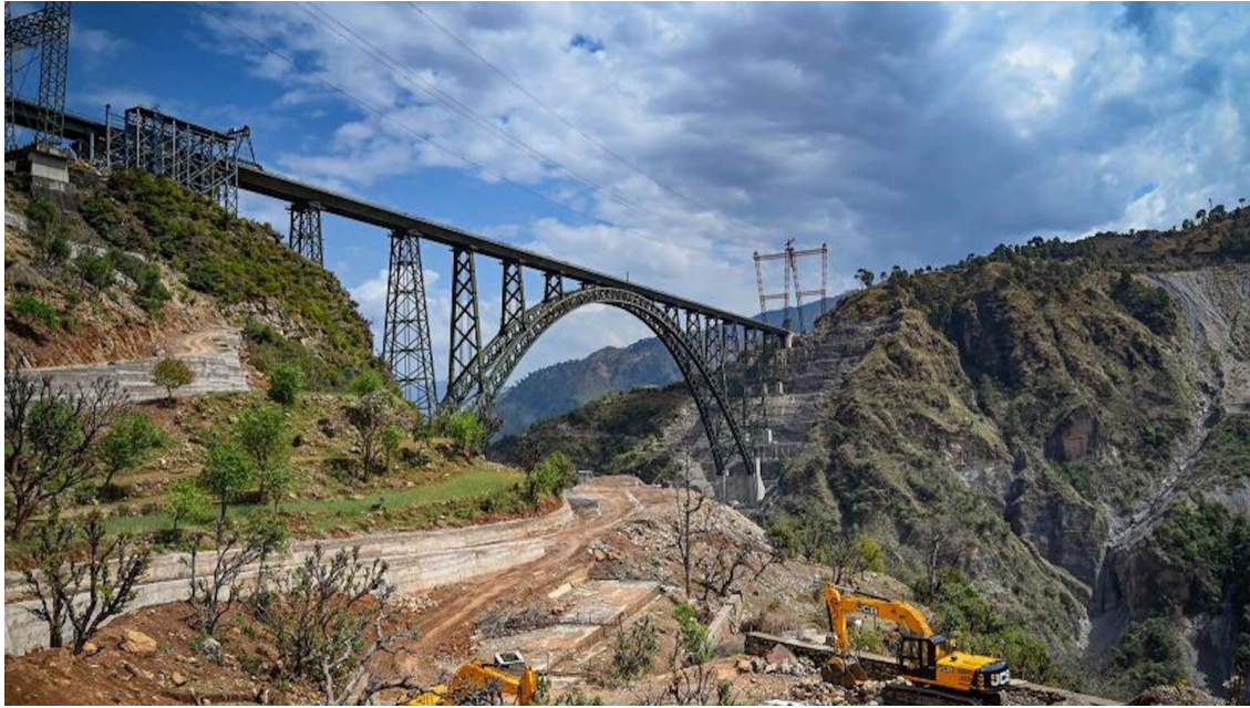
Figura 2-9 India tiene el puente ferroviario más alto del mundo (julio-2023). Fuente: Autores.
