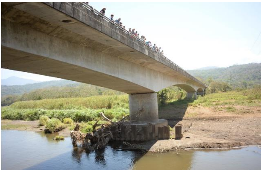
Figura 2-2 Puente sobre el río grande de Tárcoles, Costa Rica. Fuente: LanammeUCR,2019
