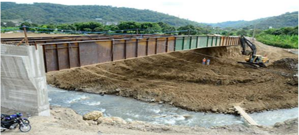
Figura 2-12 Vigas para el puente El Guabito - Manabí - Ecuador (febrero-2014). Fuente: Autores.
