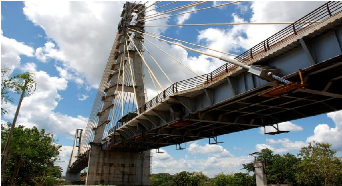
Figura 2-13 Puente atirantado sobre el río Aguarico- Ecuador. Fuente: Google Earth Pro
