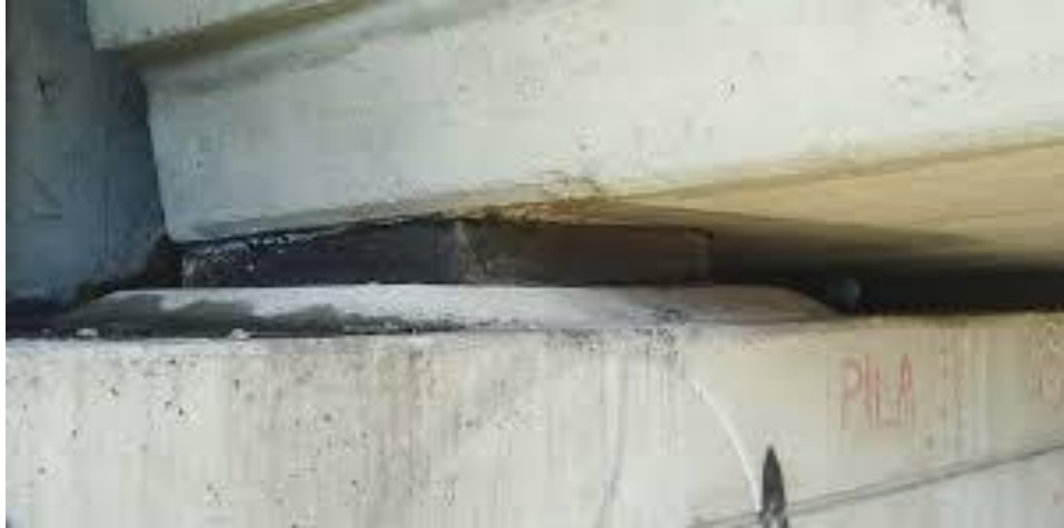
Figura 2-27 Neopreno sobre la pila y por debajo de la losa. Fuente: Rehabtec.
