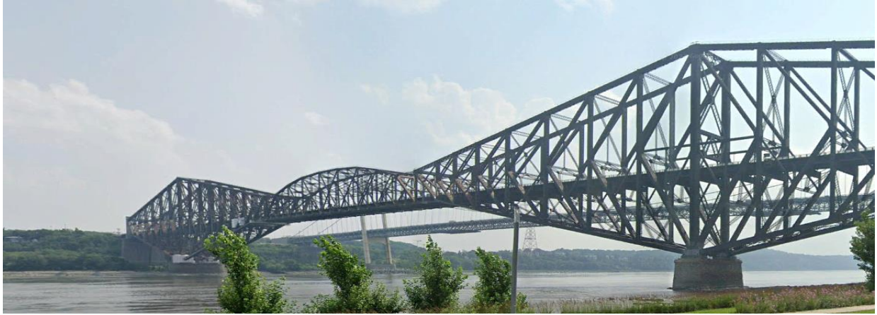
Figura 2-14 El puente voladizo más largo del mundo, en Canadá. Fuente: Google Earth Pro
