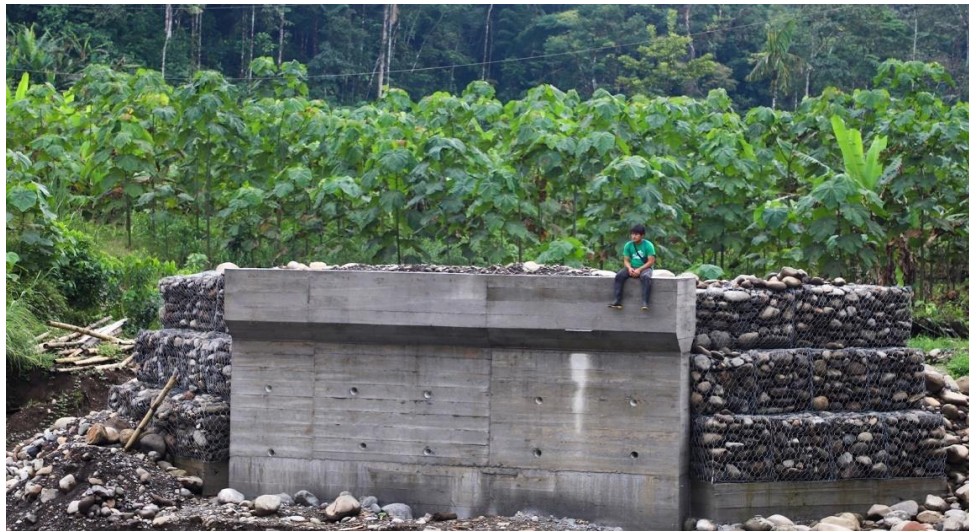
Figura 2-24 Construcción de estribos sobre el rio Namakin. (agosto-2023). Fuente: Autores.
