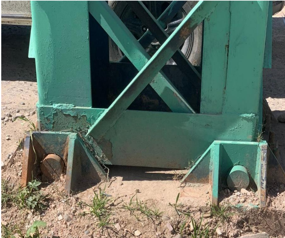
Figura 2-28 El puente "La Unidad" está apoyado por medio de rodillos, (junio-2024). Fuente: Autores.
