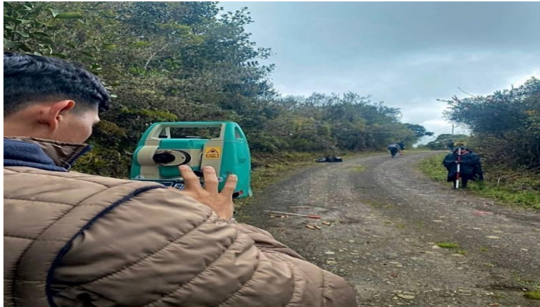
Figura 2-35 Levantamiento topográfico de una franja de la carretera que conecta al puente en Zhumir, Paute, Ecuador. Fuente: Autores.
