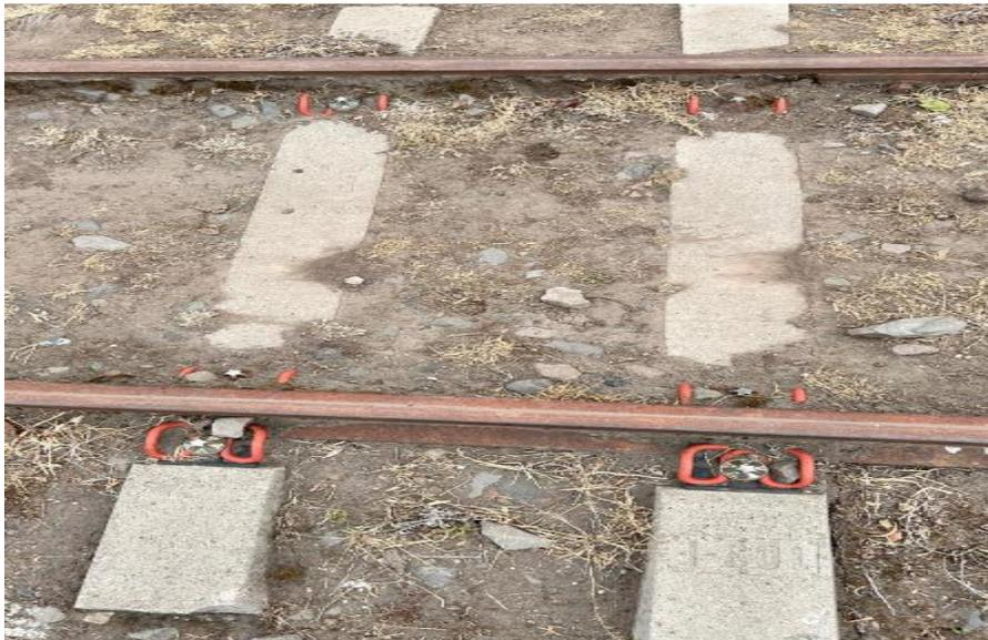
*Nota.* Los durmientes de hormigón ofrecen una solución robusta y de bajo mantenimiento para la infraestructura ferroviaria, con una vida útil considerablemente más larga en comparación con los de madera.. Elaborado por: Los autores.
