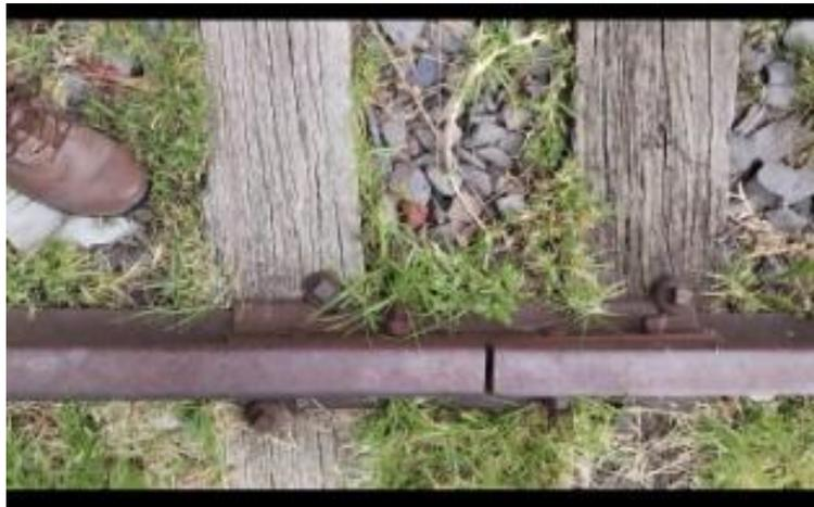
*Nota.* Estas fijaciones proporcionan una sujeción firme, su capacidad limitada para absorber vibraciones debe ser considerada en el diseño del sistema ferroviario. Elaborado por: Los autores.
