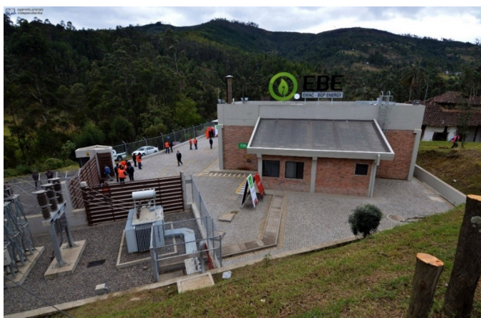
Figura 11: Planta de biogas EMAC-BGP ENENRGY [79].
