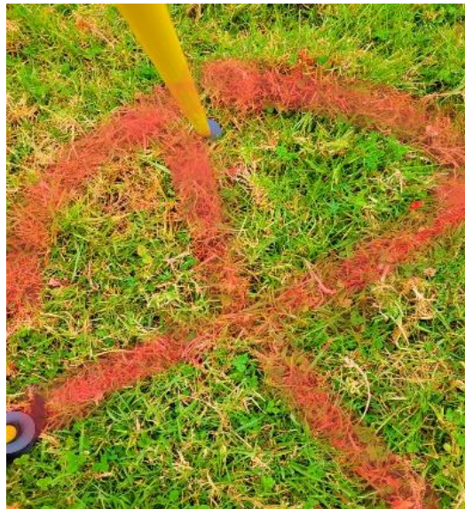
Fig. 5.2 Fijación de hito de control
