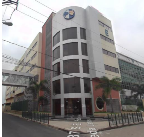
Figura 16. Edificio donde se pretende instalar el diseño.
