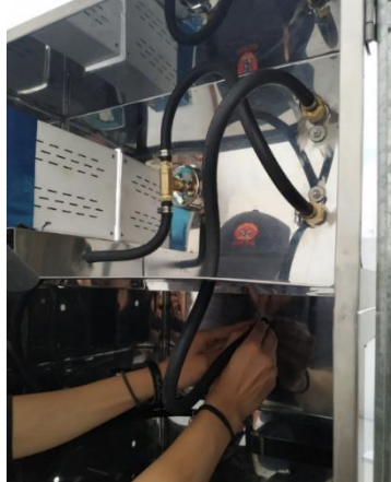
Figura 3.5: Instalación de mangueras y acoples
