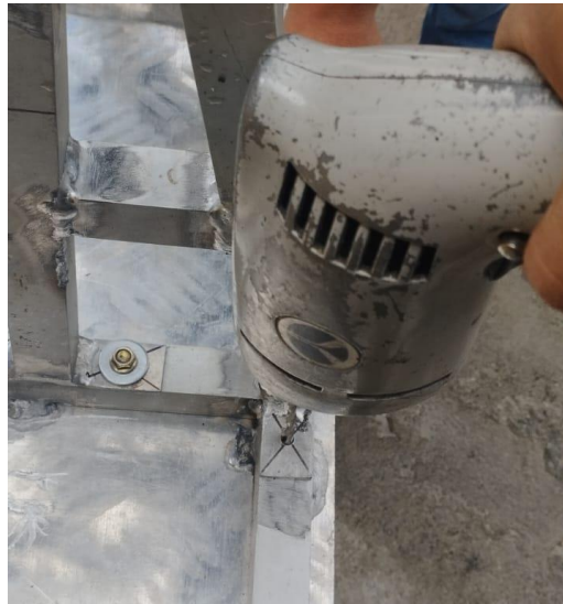
Figura 4.20: Perforación de base espaldar y estructura de rueda
