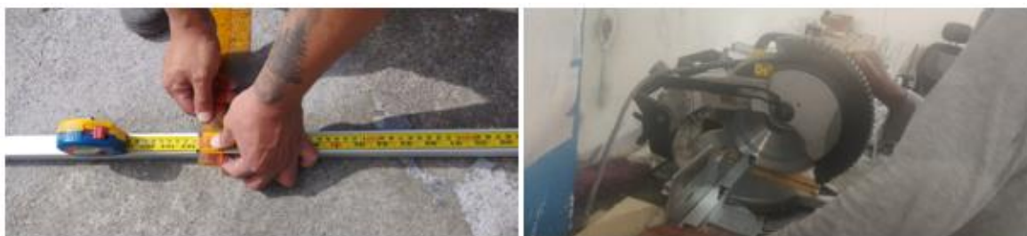
Marcado y corte del perfil cuadrado para construcción del bastidor, Fuente: C. Ojeda y C. Quinche
