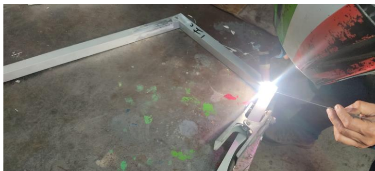
Figura 4.13: Soldadura de sección frontal del bastidor.
