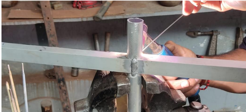
Figura 4.16: Soldadura Bases de dirección.
