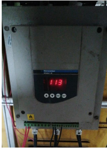
Figura 37. Prueba de arrancador.
