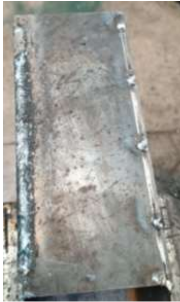
Figura 2.12 Soldadura de piezas
