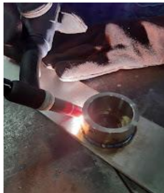
Figura 32. Proceso de soldadura TIG.
