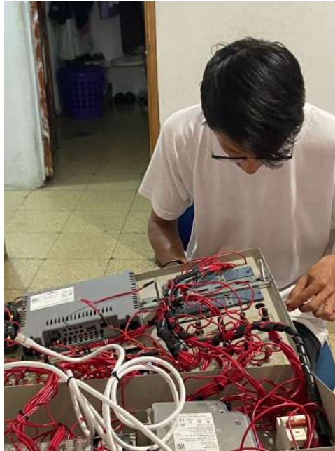
Figura 38. Instalación de componentes del módulo. Fuente: Autores.
