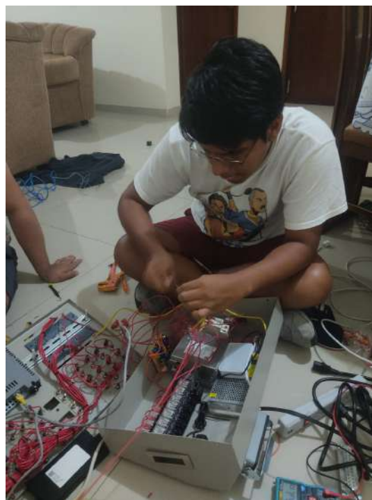
Figura 39. Instalación de componentes del módulo. Fuente: Autores.
