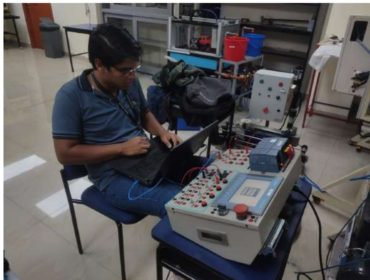
Figura 43. Prueba de conexiones del módulo. Fuente: Autores.
