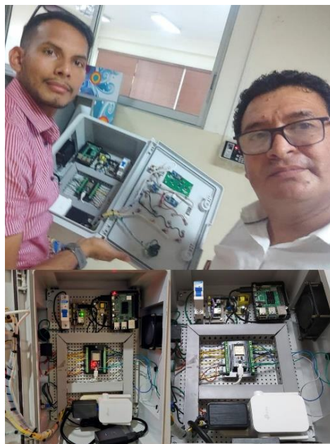
Figura 48: Prueba de equipos conectados a la red
