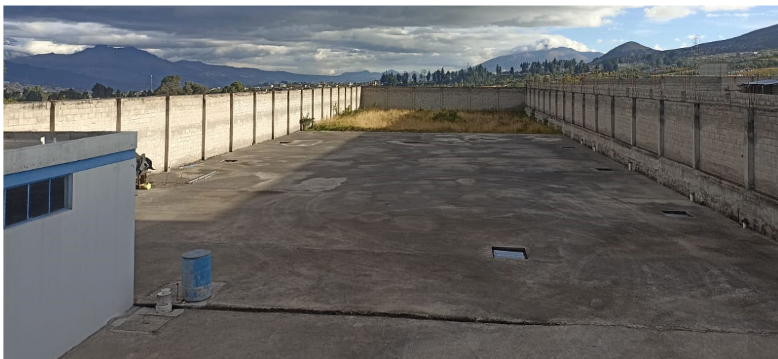
Figura 9. Área de construcción
