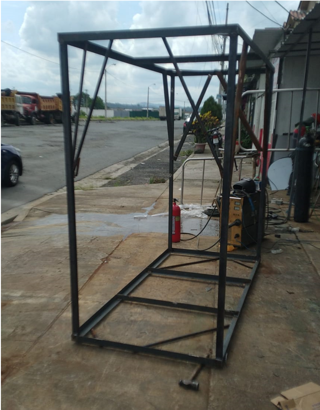
Figura 46. Ensamblaje de estructura, Fuente: J.Ramirez, B.Ureta
