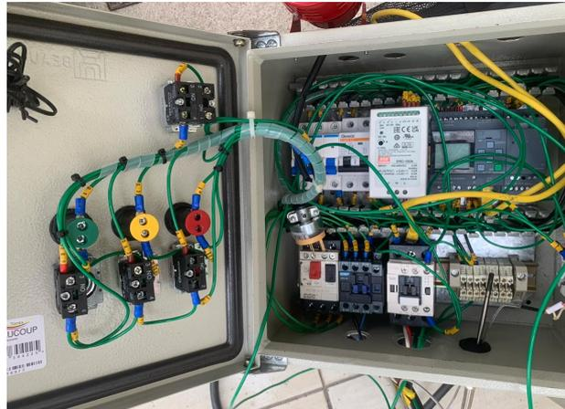
Figura 41. Gabinete Metálico - Conexiones de Componentes Electrónicos, **Fuente:** Autores.
