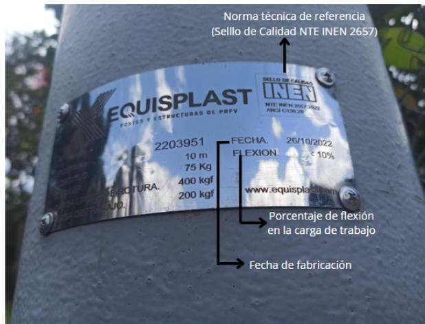
Figura 25: Partes de la Placa de Identificación - Parte 2
