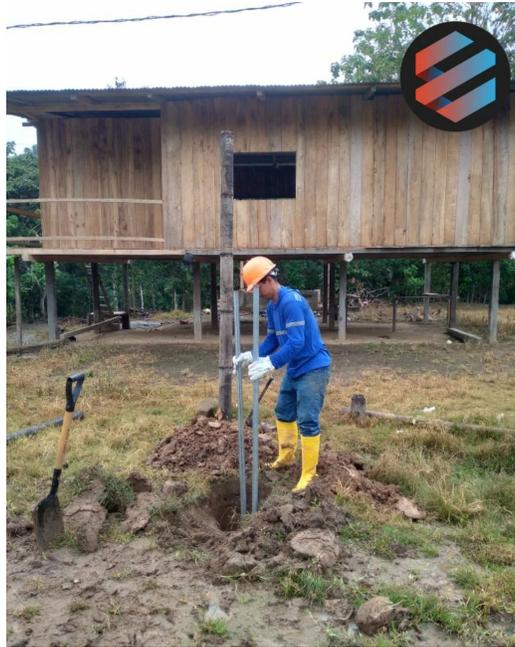
Figura 31: Excavación manual para implantación de Postes
