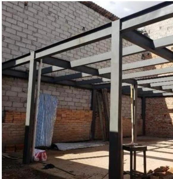
Figura 1. Obra civil con acero estructural.
