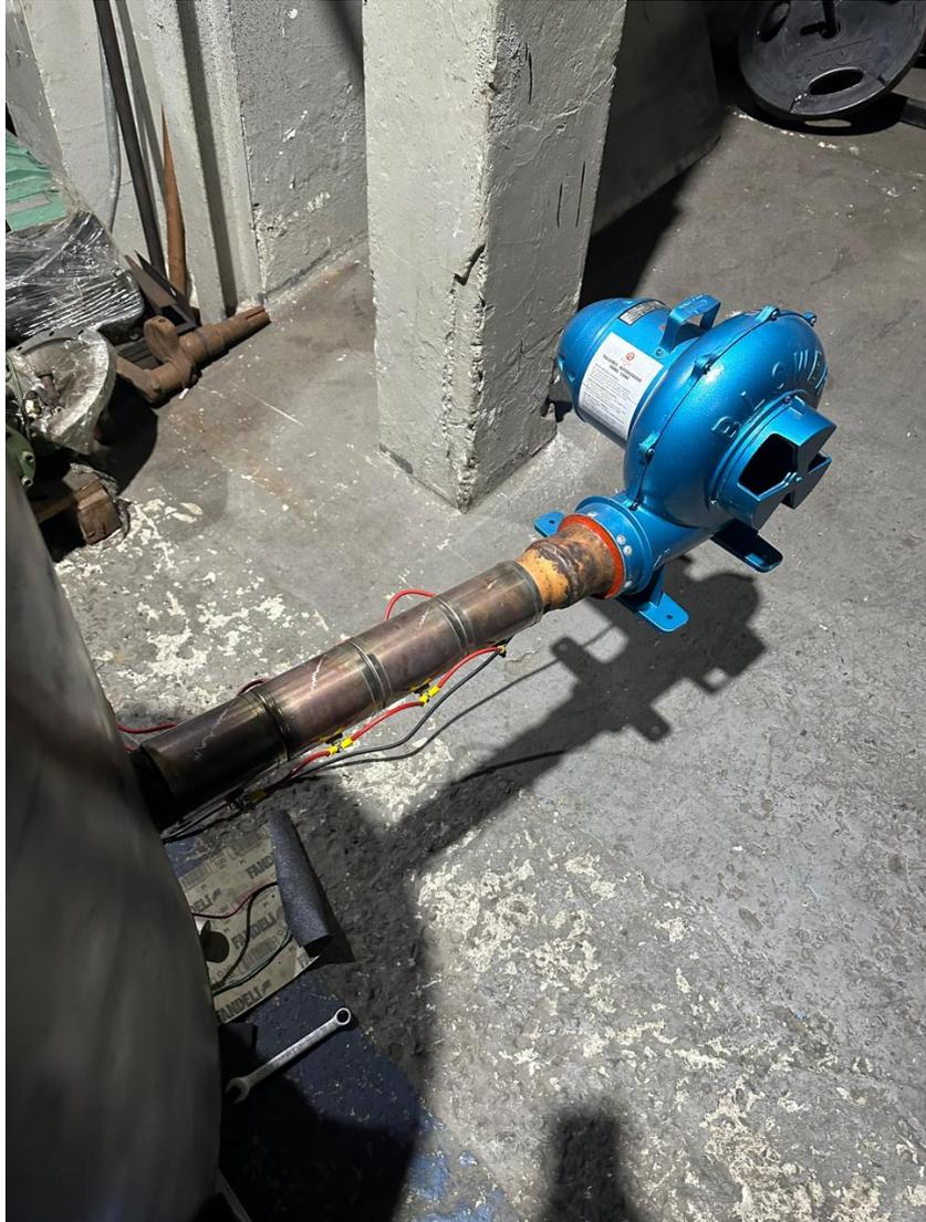
Figura 57. Blower conectado al tubo de resistencias, por M. Granados y M. Vásquez.
