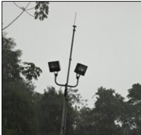
Figura 2.1: Iluminación exterior instalada en poste. Fuente Autor
