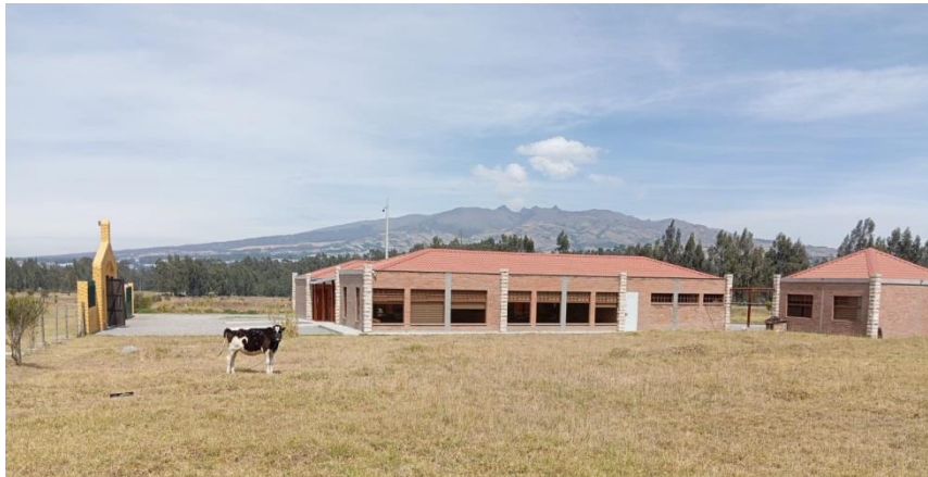
Figura 3.2 Área de construcción en la estación de la UPS.
