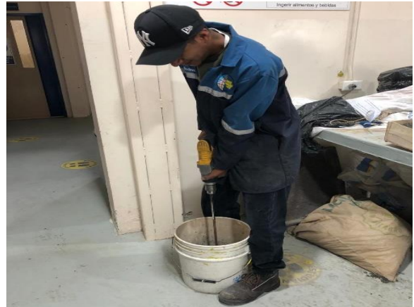
Figura 6. Mezclado con taladro.
