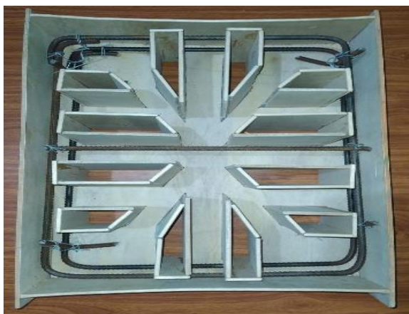
Figura 8. Molde de rejilla de sumidero vial.
