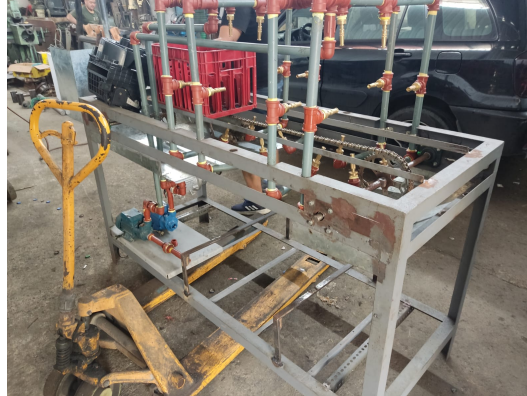
Figura 52. Prueba del Sistema de Lavado
