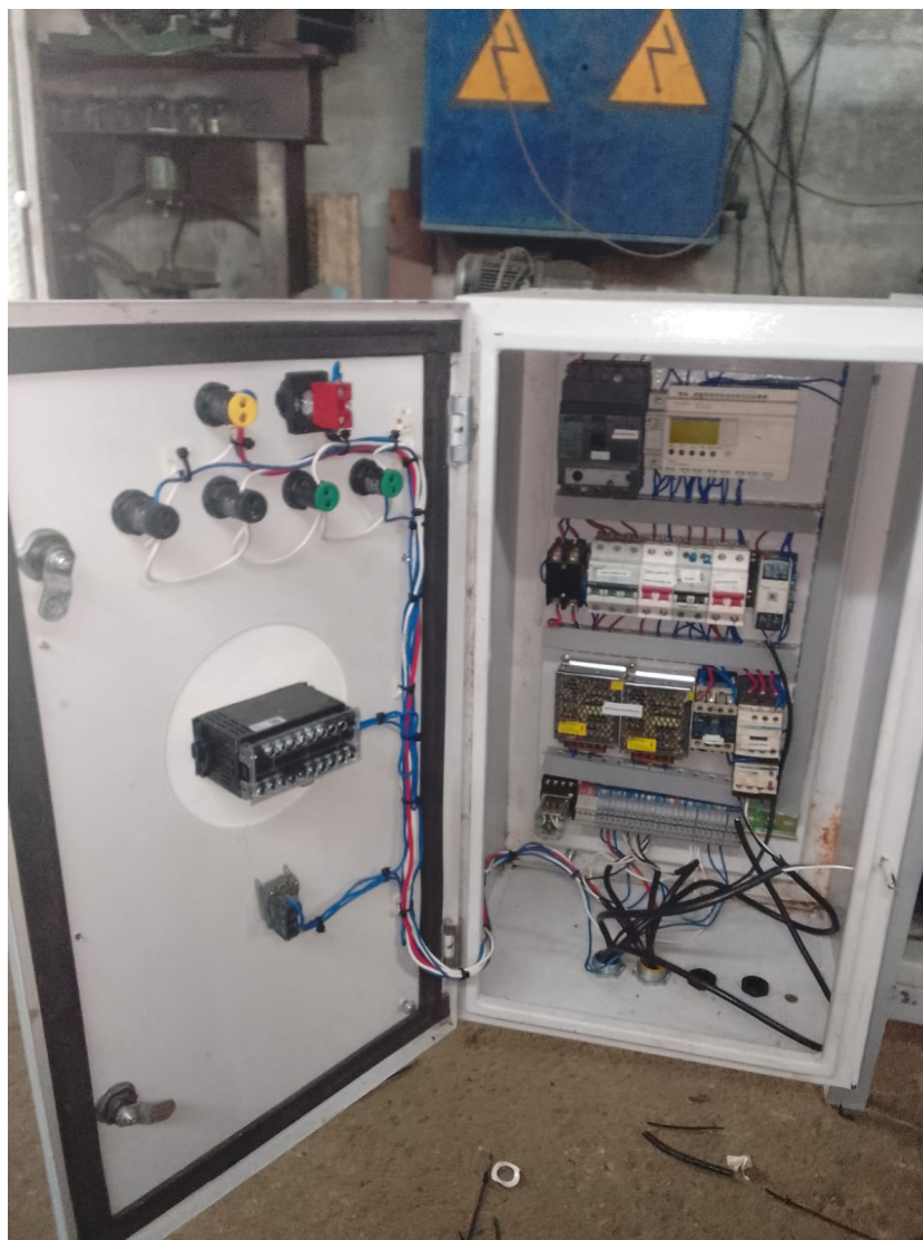
Figura 84. Presentación de botoneras hacia el tablero. Fuente: Realizado por Daniel Remache y Josh Sud.
