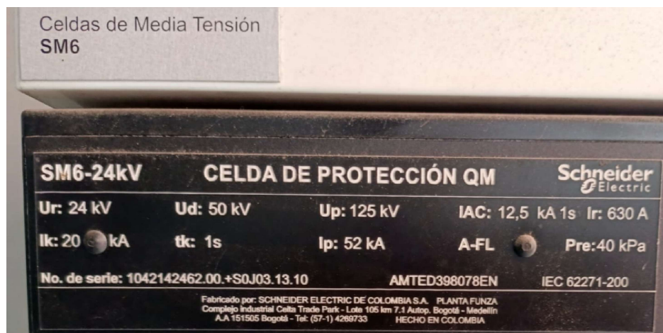
Figura 16: Celda MT seccionador - fusible SM6 QM 24kV Contactos, manual, 630 A, 20 kA. Fuente autoría propia. Ficha técnica en el siguiente url: https://www.se.com/co/es/product/SM61Q3JHH6Z7CONTA/celda-mt-seccionador-fusible-sm6-qm-24kv-contactos-manual-630a-20ka/
