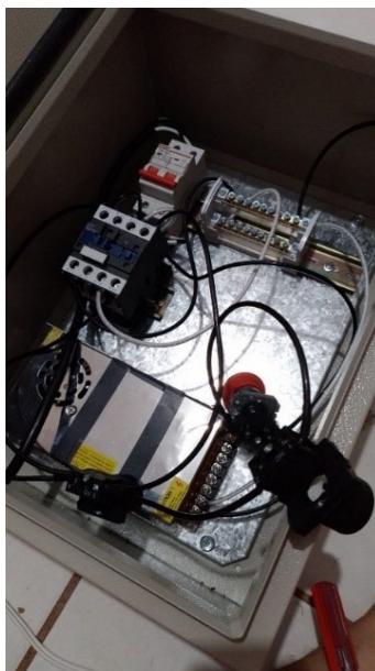
Figura 59. Implementación del distribuidor de carga y fuente.
