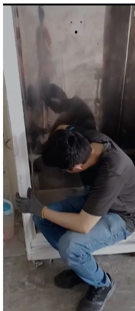
Figura 48. Implementación y restauración de lamina de acero.
