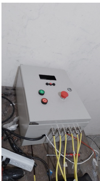
Figura 60. Implementación de las botoneras y del cableado.
