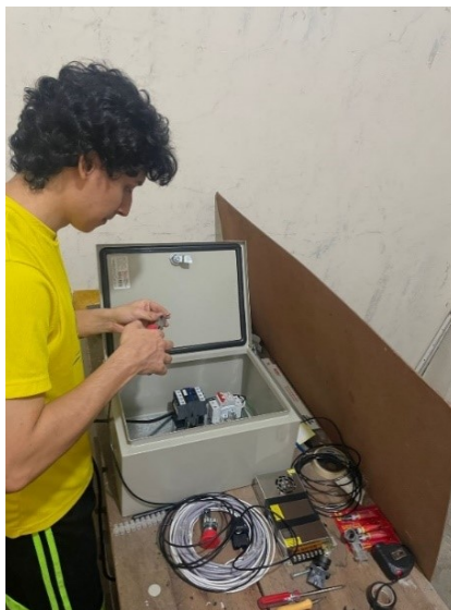
Figura 57. Implementación del breaker general y contactor.
