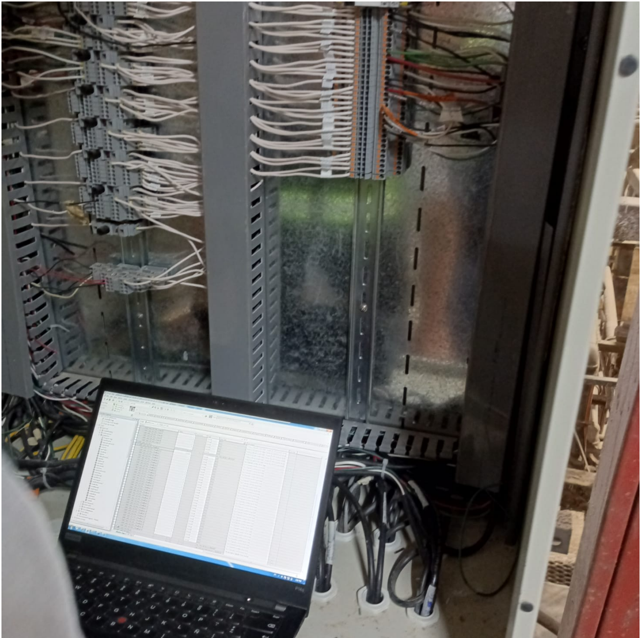
Figura 68: Comisionado de señales en tablero de control. Fuente: Autoría Propia
