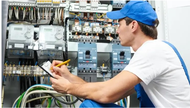
Figura 2: Automatización Industrial. Fuente: [3]
