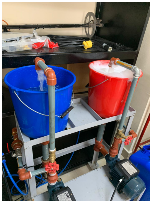
Figura 18: Tanques de agua Fuente: Autores
