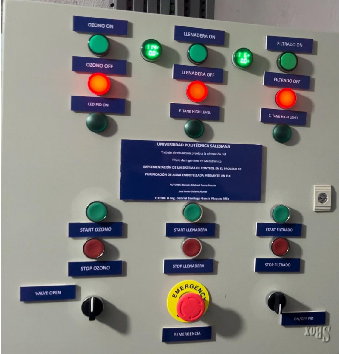
Figura 65. Intalación de Tablillas en el Tablero. Solano y D. Ponce
