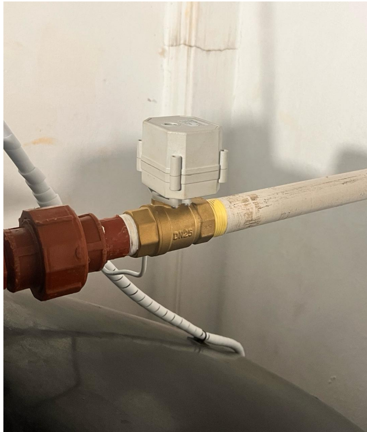
Figura 62. Intalación de valvula motorizada, por J. Solano y D. Ponce
