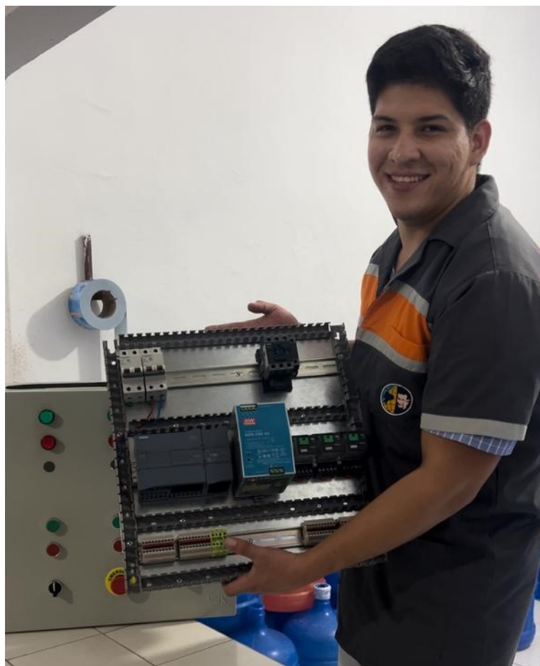
Figura 58. Instalación de los elementos en la placa de sujeción, por J. Solano y D. Ponce
