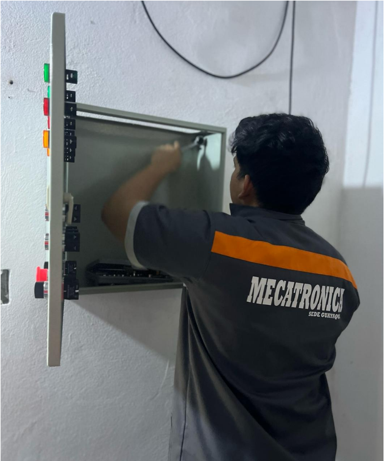
Figura 56. Instalación del Tablero, por J. Solano y D. Ponce
