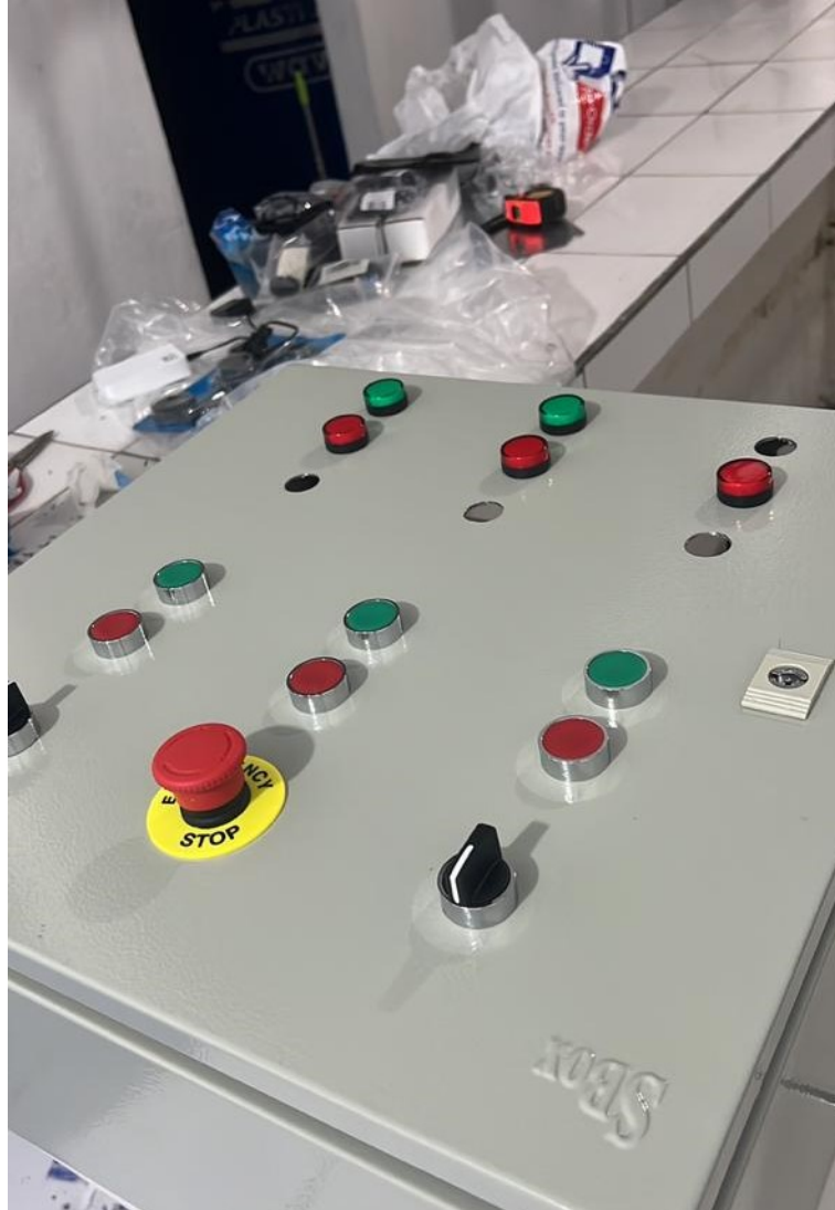
Figura 55. Instalación de pulsadores, por J. Solano y D. Ponce
