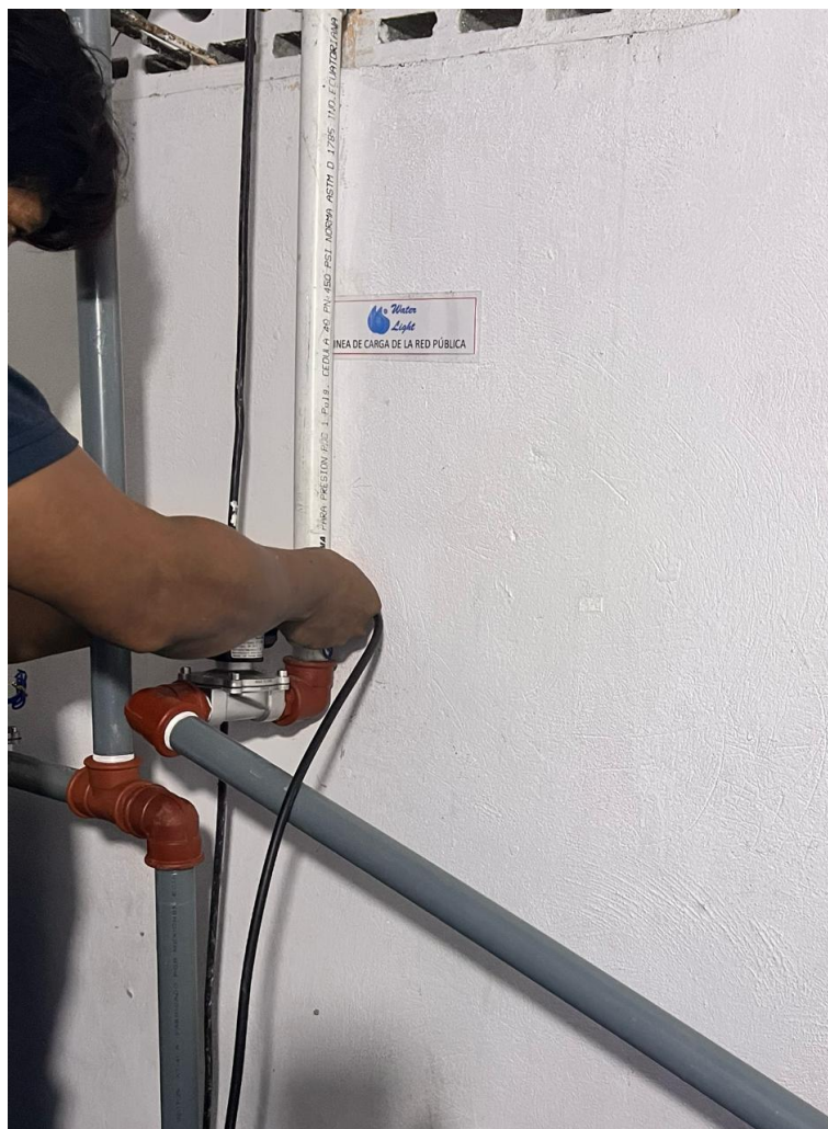
Figura 61. Intalación de valvula solenoide, por J. Solano y D. Ponce
