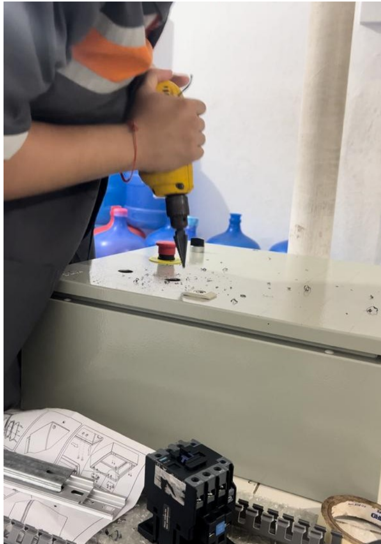
Figura 19. Perforación de los agujeros en tablero de Control/Fuerza
