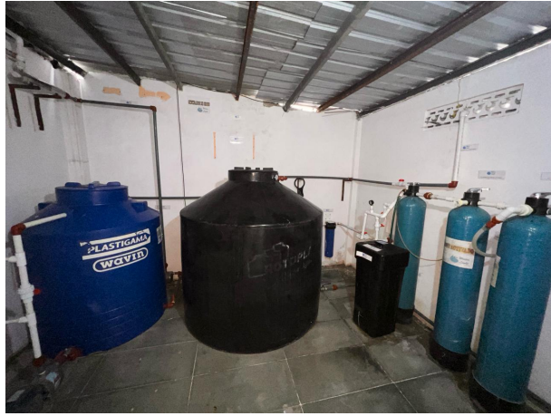
Figura 2. Instalación de equipos de Filtración para el Agua embotellada.
