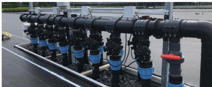
Figura 12. Sistema de abastecimiento de agua potable. Fuente: [46]
