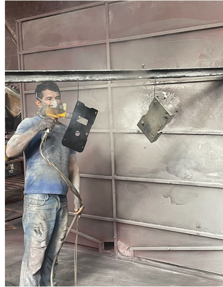
Figura 44. Pintado de estructura. Fuente: Autores.
