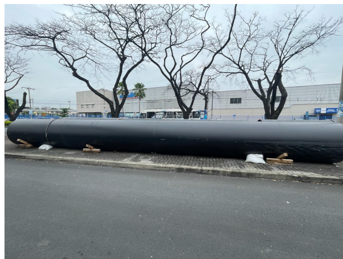
Figura 33. Tubería. Fuente: Autores.
