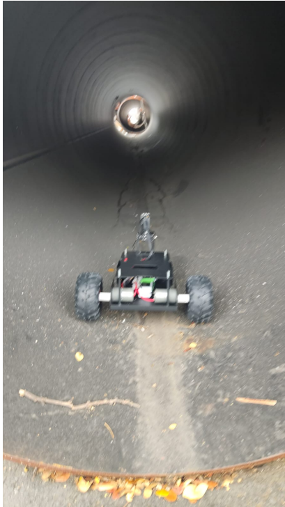
Figura 31. Inicio de tubería. Fuente: Autores.
