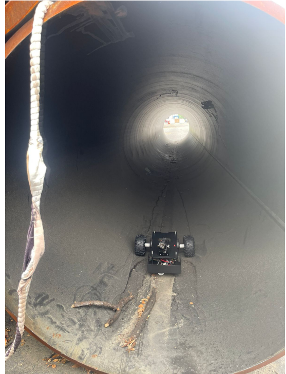
Figura 32. Fin de tubería. Fuente: Autores.
