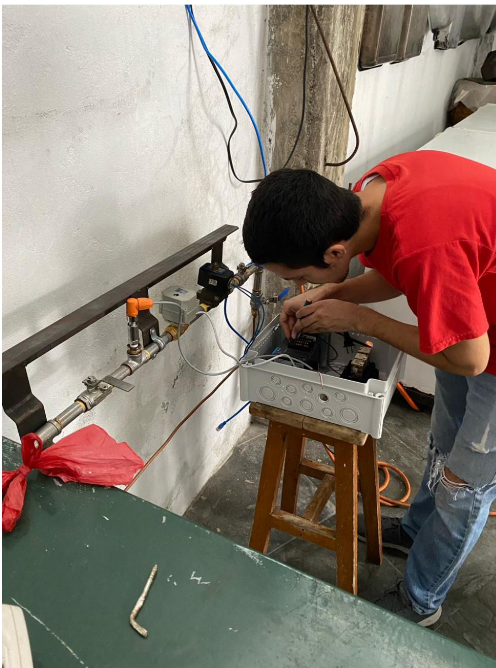
Figura 87. Conexiones de equipos en el tablero de control para el sistema automatizado, por A. Chafra y N. Alava
