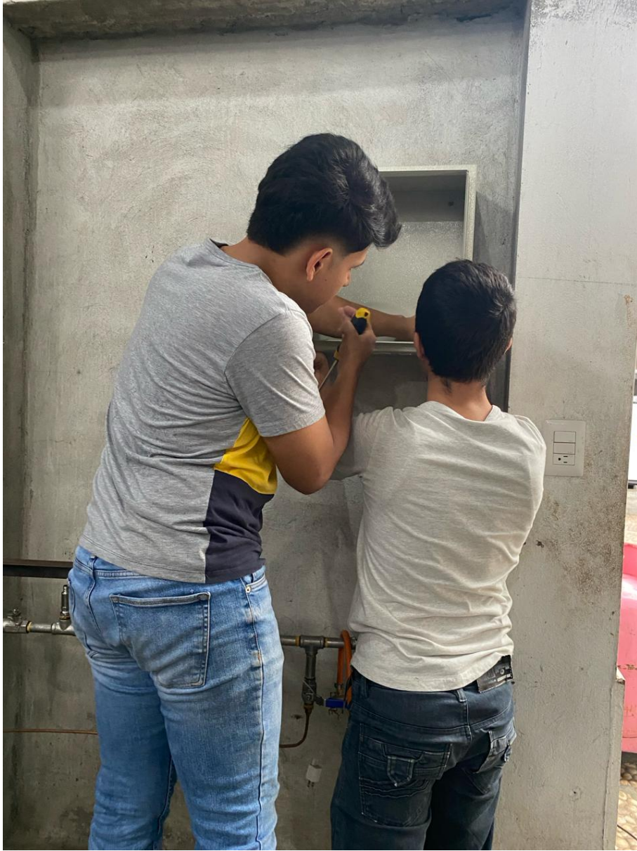
Figura 93. Colocación del tablero en la Ubicación fija, por A. Chafra y N. Alava
