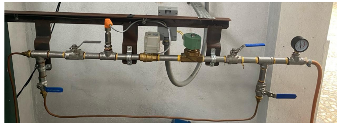
Figura 69. ensamble de la línea de automatización Fuente: Por A. Chafra y N. Alava
