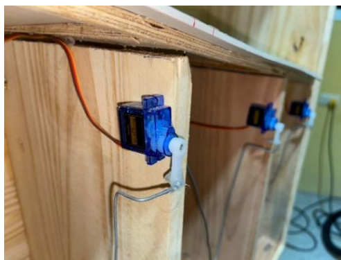
Figura 14.- Instalación de servomotores para compuertas automáticas. (Autores, 2024)
