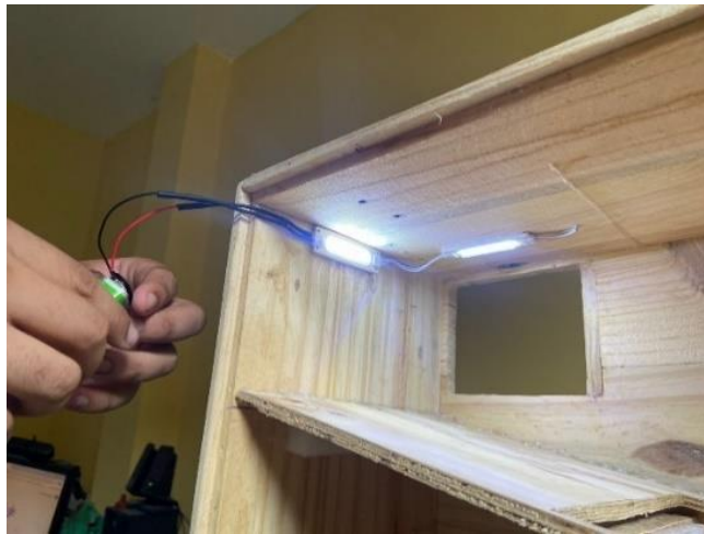
Figura 13.- Instalación de luces LED .(Autores, 2024)
