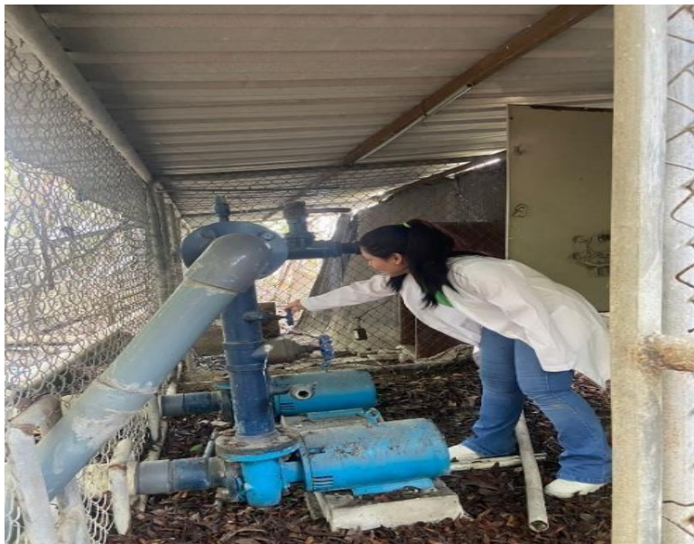
Anexo Fotográfico 2. Abrir llave de Bomba de Agua que conectan con el Río Daule para recolección de agua.
