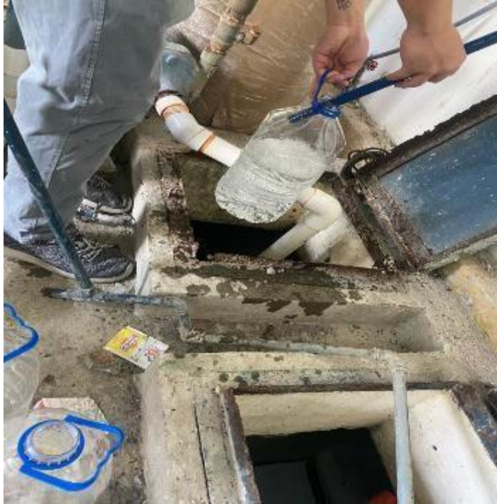
Anexo Fotográfico 19. Filtro ubicado en bomba y se dispone a sacar muestra de agua ya con filtro instalado.
