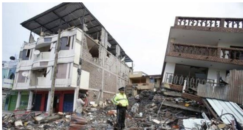
Daños estructurales producido por fenómenos sísmicos en Manabí
