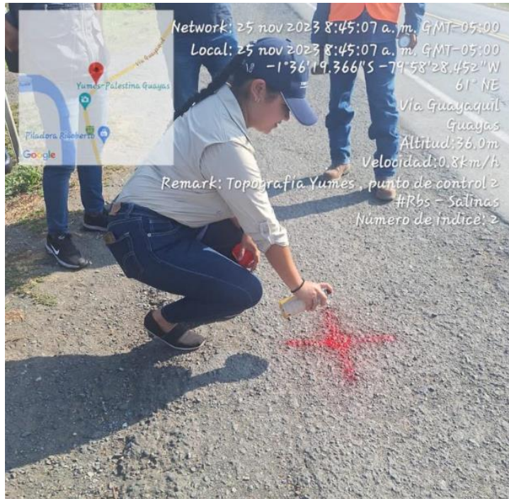
Imagen 13 Colocación de puntos base, para la topografía con estación total en el recinto Yumes, Palestina.
