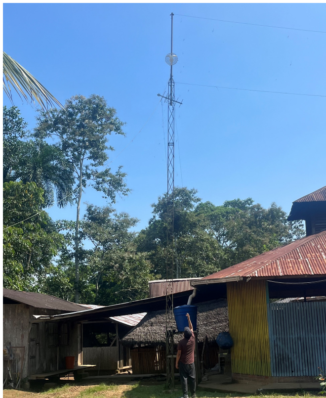
Figura 2.5: Torre secundaria 9 metros de altura.
