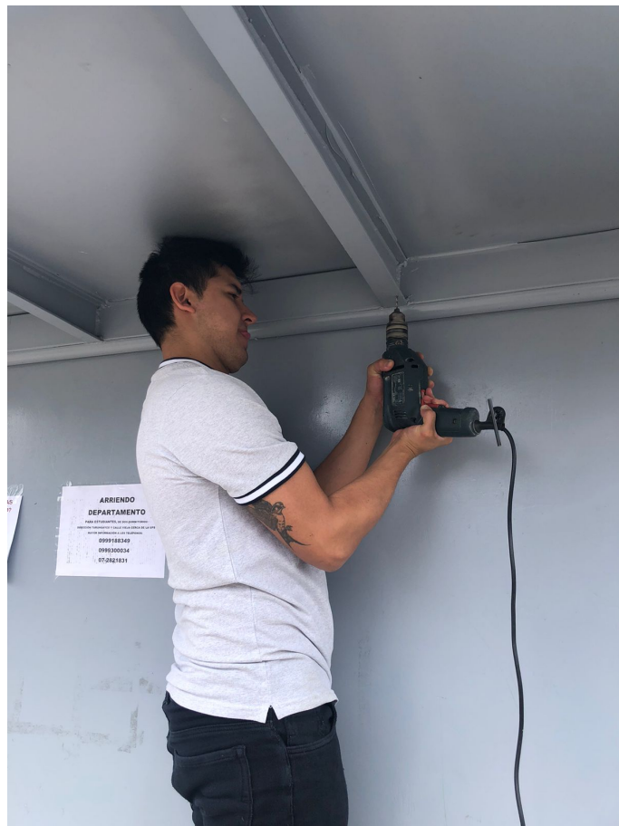
Figura 11: Colocación de pernos en la parte superior de la parada de bus para la implementación del alucubond y luminarias
