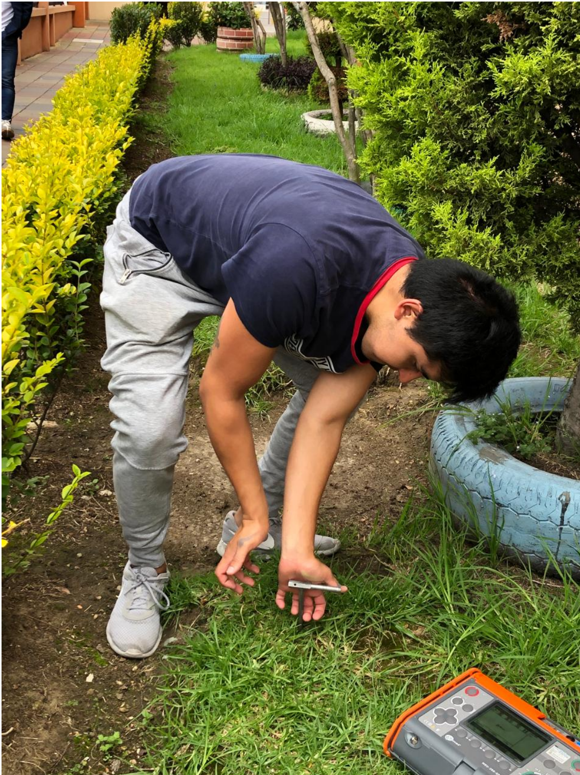
Figura 25: Instalación de Picas para puesta a tierra.
