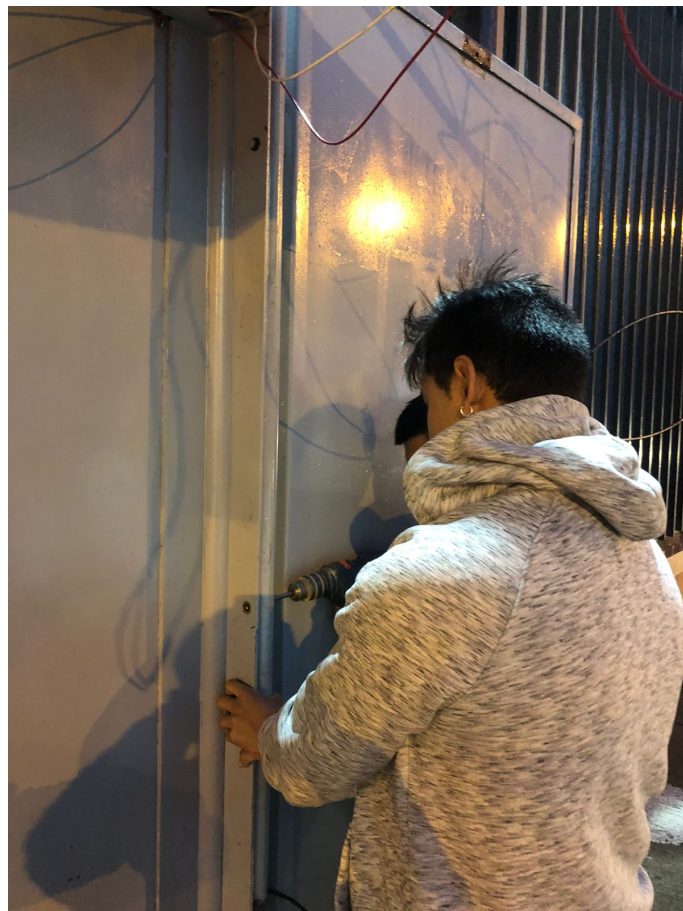
Figura 13: Colocación de pernos en la parte de la tubería para poder colocar el panel fotovoltaico
