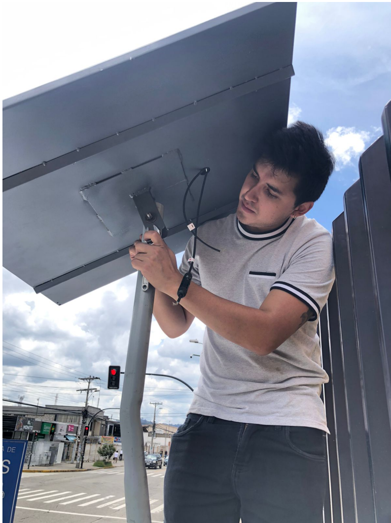
Figura 16: Colocación del panel solar con su estructura con una inclinación de 30 grados
