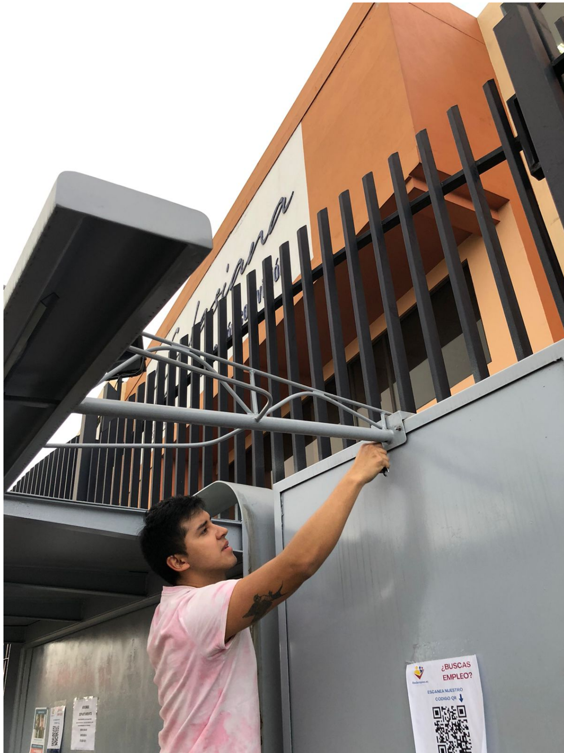
Figura 21: Desmontamiento de valla publicitaria para instalacion de luminarias
