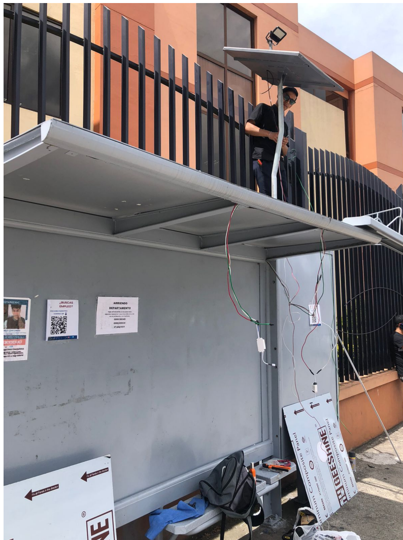
Figura 18: Instalación de cableado en la parte superior de la parada con las conexiones de carga
