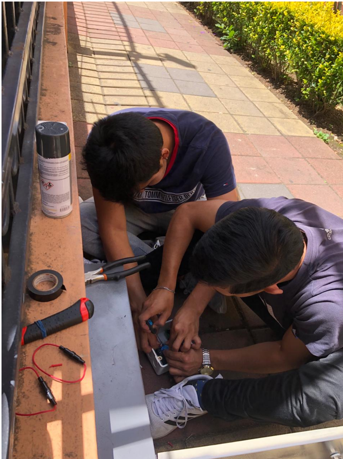
Figura 33: Ajuste y colocación del timer en la caja del circuito.
