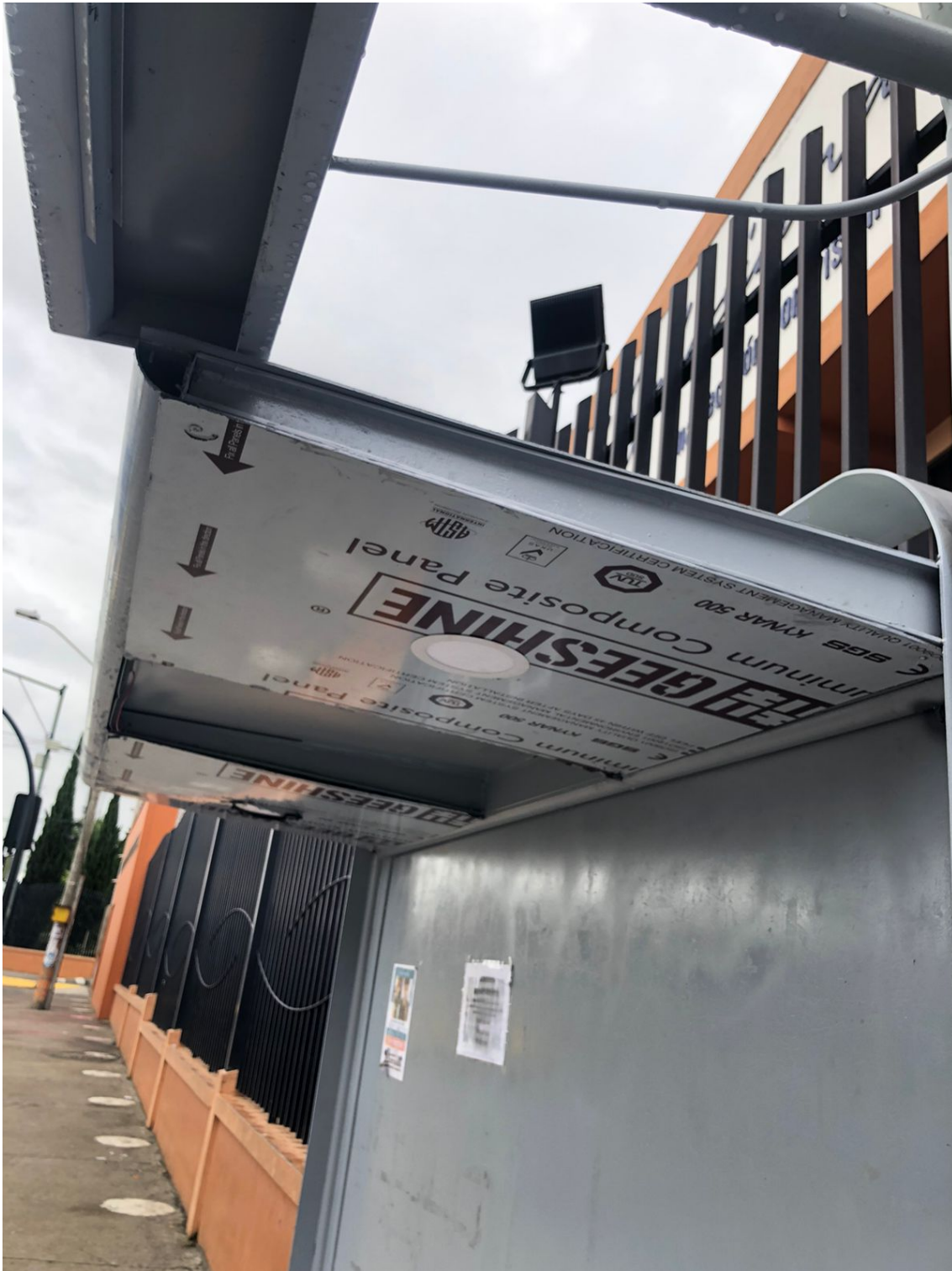
Figura 20: Instalación de alucubond y luminarias.
