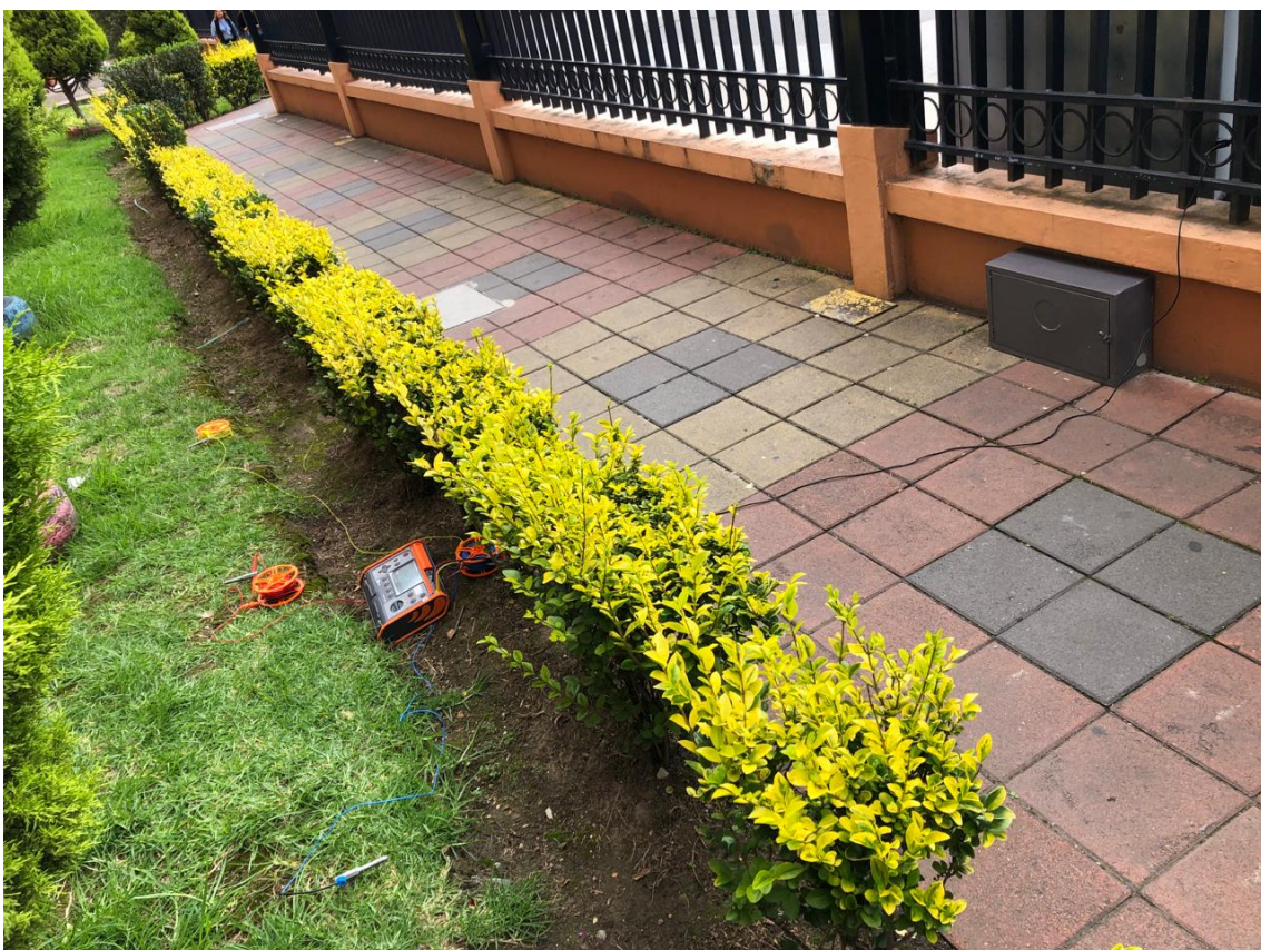
Figura 27: Teluometro instalado en paralelo.
