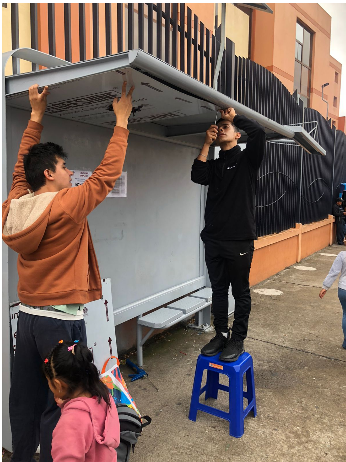
Figura 19: Colocación de alucubond.
