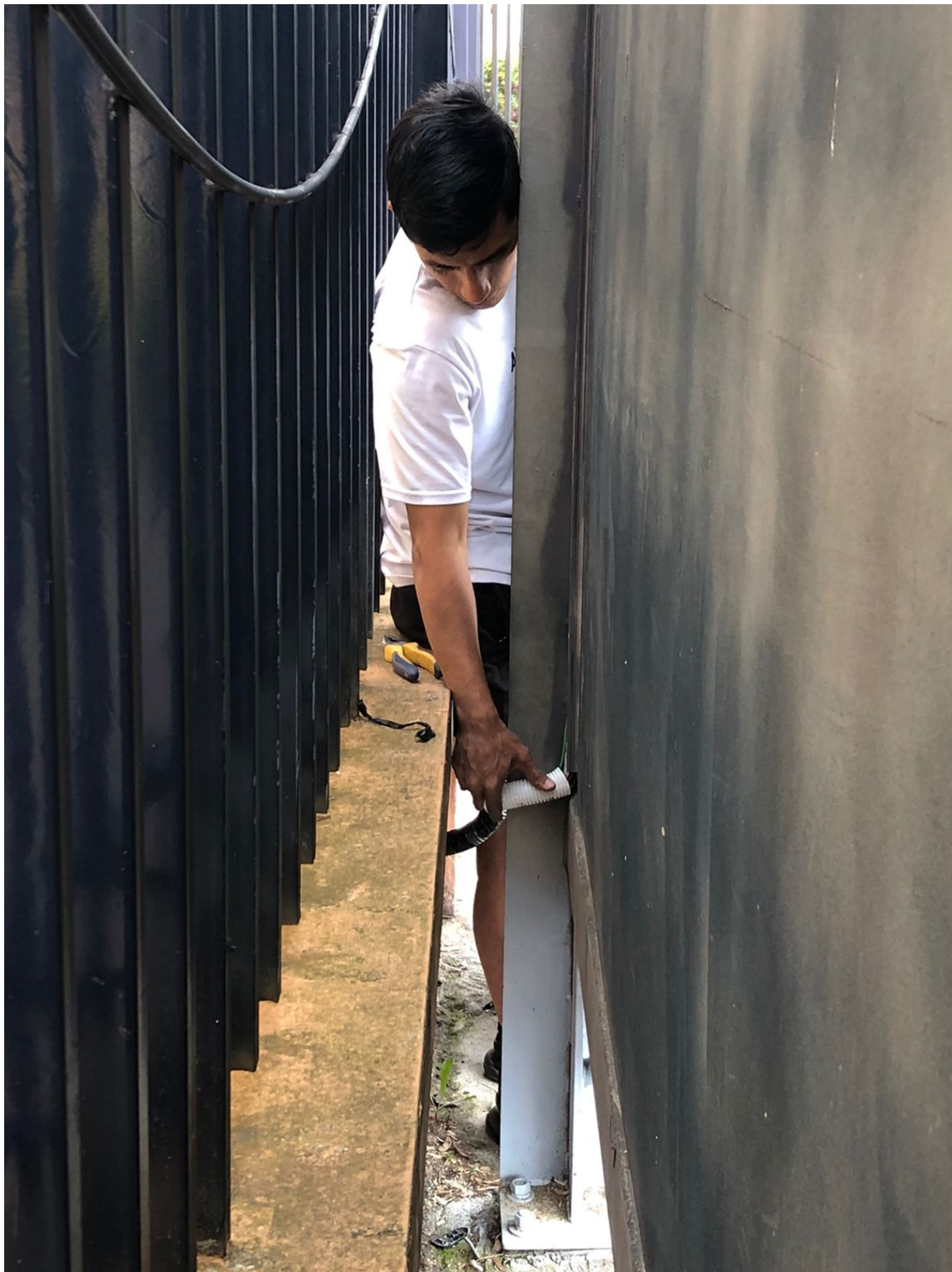
Figura 34: Instalación de tuberías en la parte trasera de la parada de bus.
