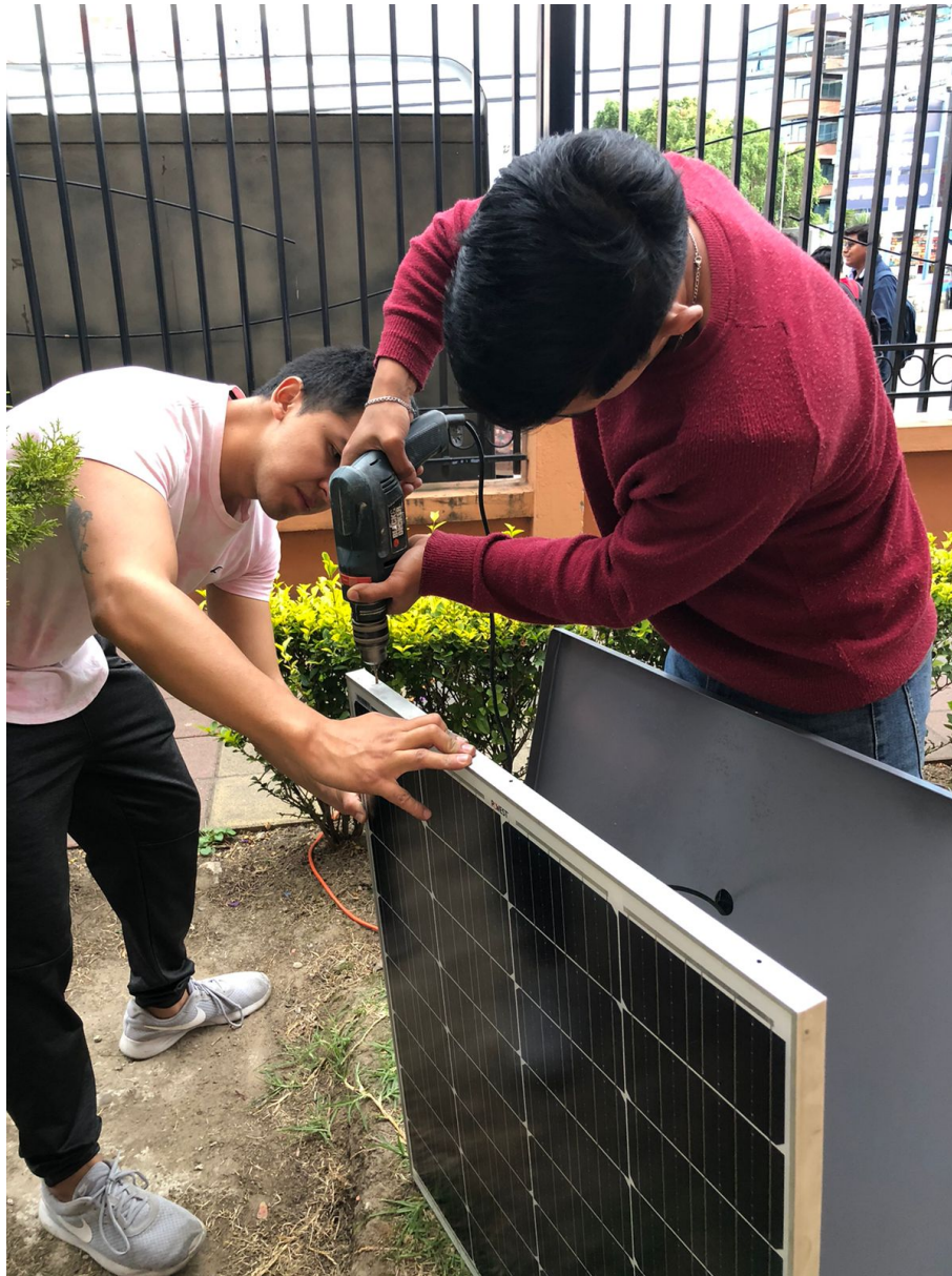
Figura 14: Instalación de pernos en la parte externa del panel fotovoltaico
