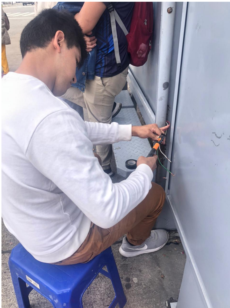
Figura 17: Instalación de cableado de panel solar
