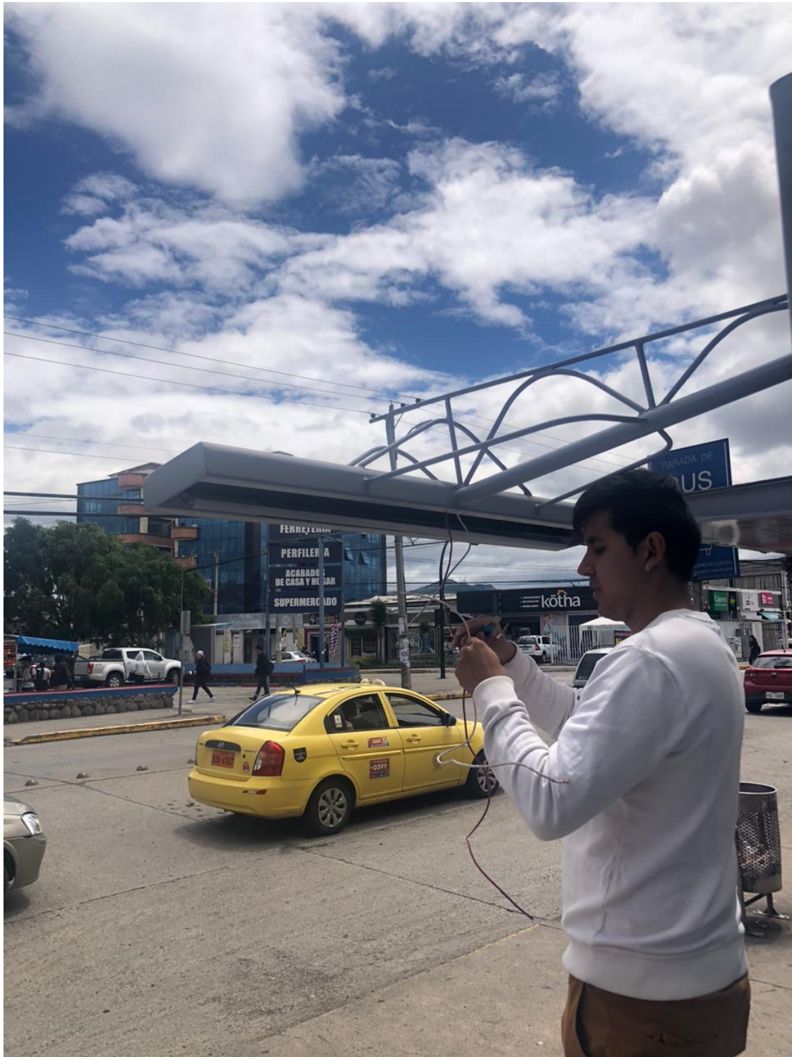
Figura 22: Instalación de cableado a la valla publicitaria.
