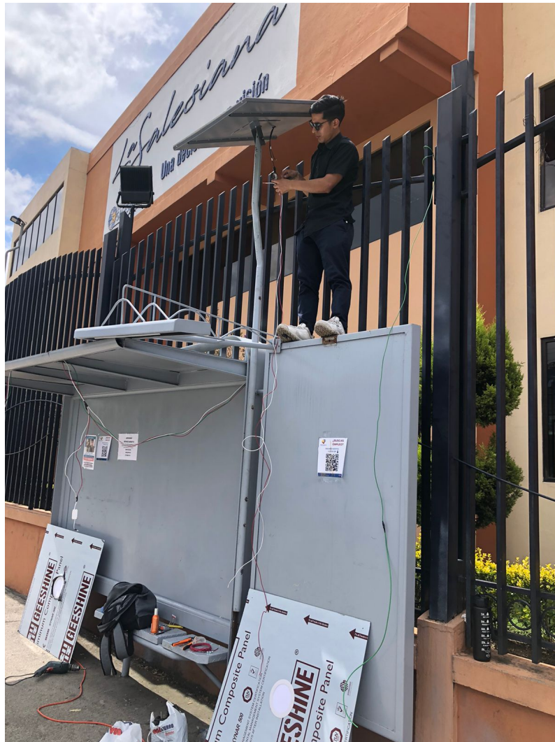
Figura 15: Montaje de estructura para el panel solar
