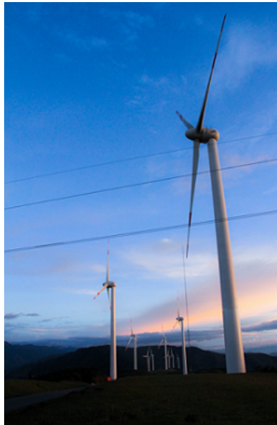
Figura 4: La Central Eólica Villonaco Loja - Ecuador [4].
