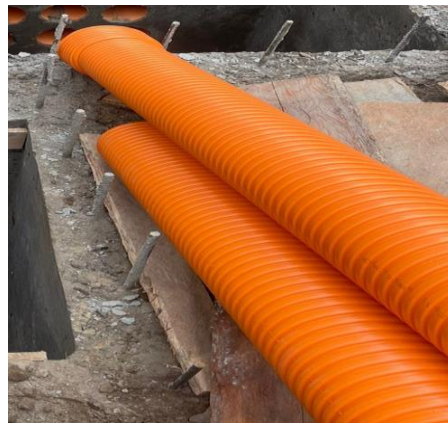
Figura 23. Tubería Eléctrica para Redes de MV y BV
