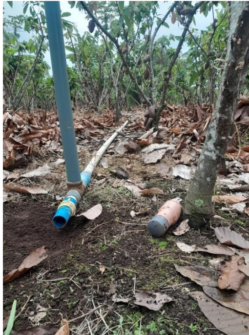
Imagen 29: Conexión y puesta de codo
