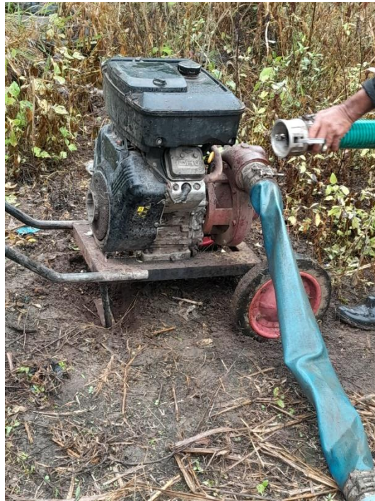
Imagen 30: Conexión de tuberías madres
