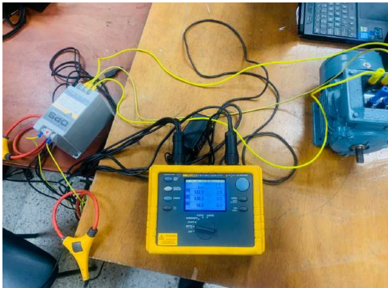
Figura C.4: Medición con medidor de calidad de energía.
