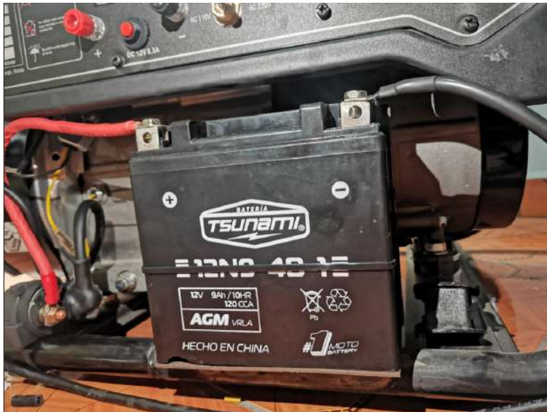
Figura A.2: Montaje de Batería.
