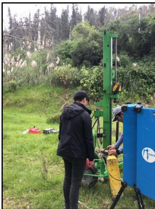
Ilustración27: Ensayo SPT fuente (GEO & GEO CIA. Ltda.)
