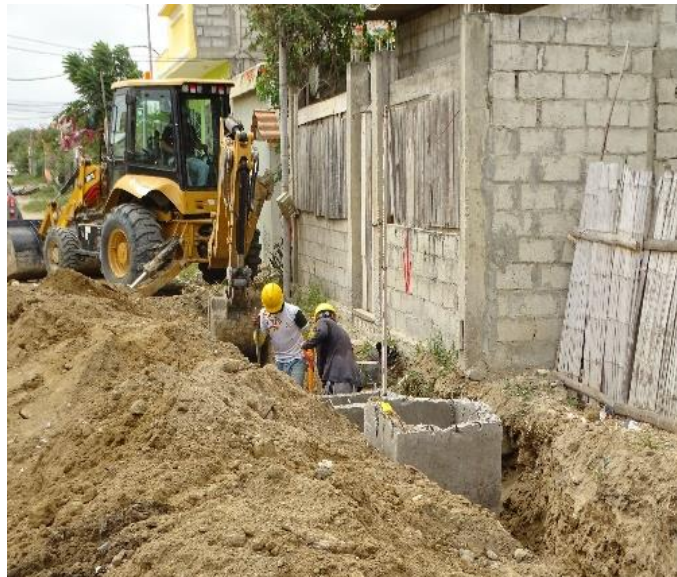
Fotografía 1. Instalación de alcantarillado. Barrio La Unión.
