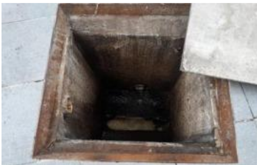
Registro Fotográfico No. 10
