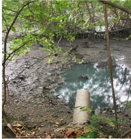
Imagen 6. Tubería de descarga localizada P2, directa al ecosistema
