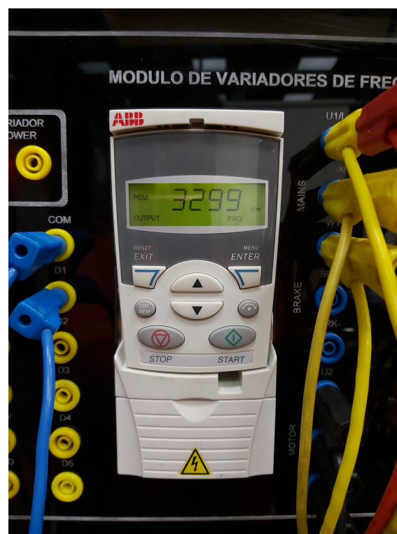
Figura 3.2: Velocidad máxima configurada para las bombas de agua.
