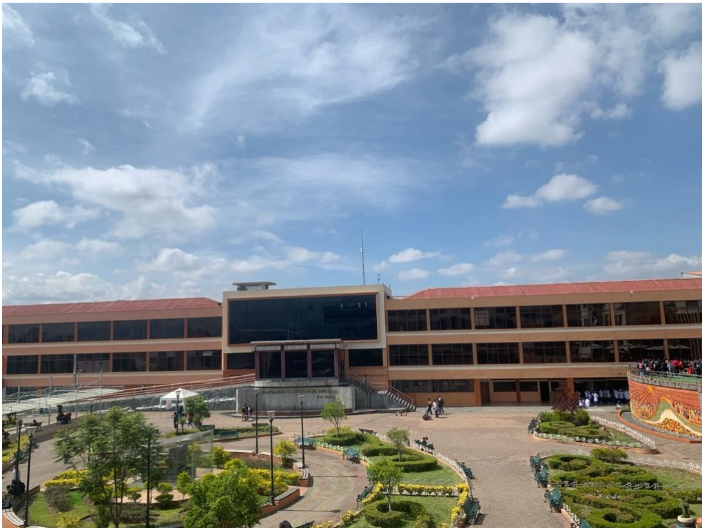
Figura 3.4: Edificio Cornelio Merchán Fuente: Autores
