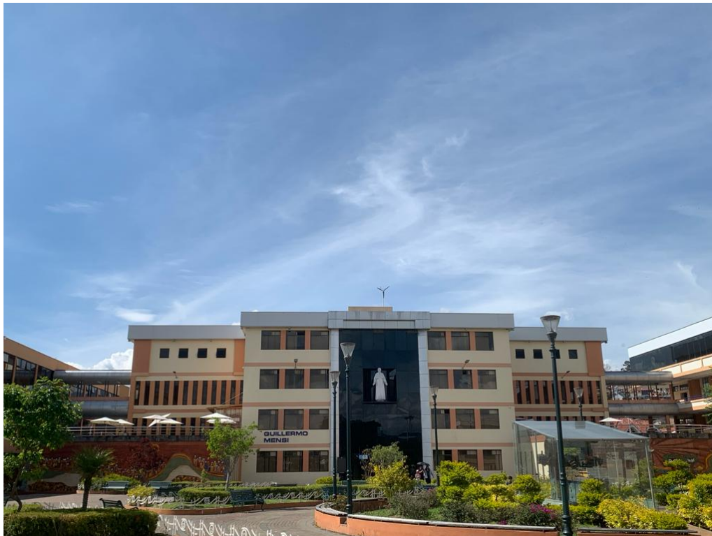
Figura 3.5: Edificio Guillermo Mensi Fuente: Autores
